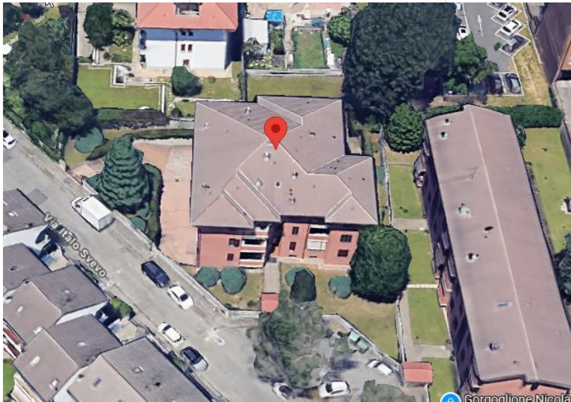
VISTA ASSONOMETRICA DA GOOGLE MAPS DEL FABBRICATO
