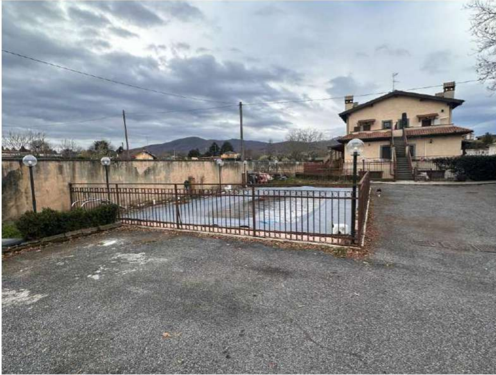
Foto 3 – La piscina condominiale e sua delimitazione
