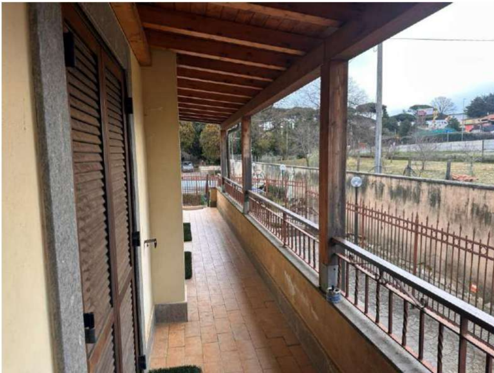
Foto 6 – Terrazzo perimetrale appartamento int.5
