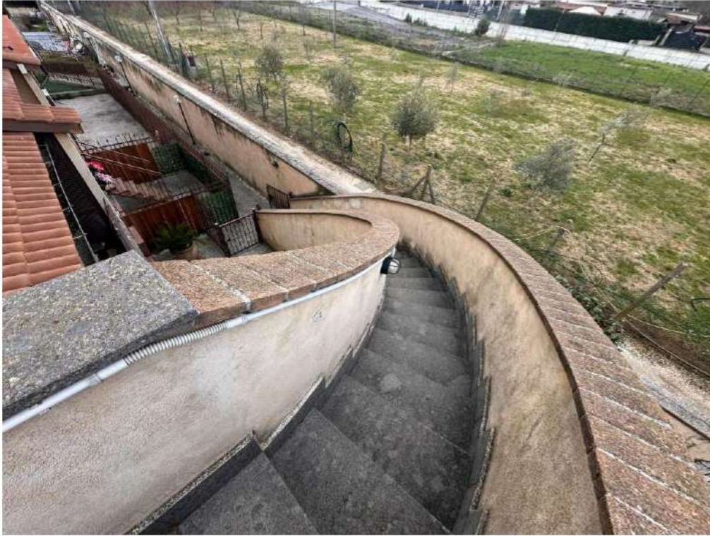
Foto 11 – Appartamento int.6: scala esterna di accesso
