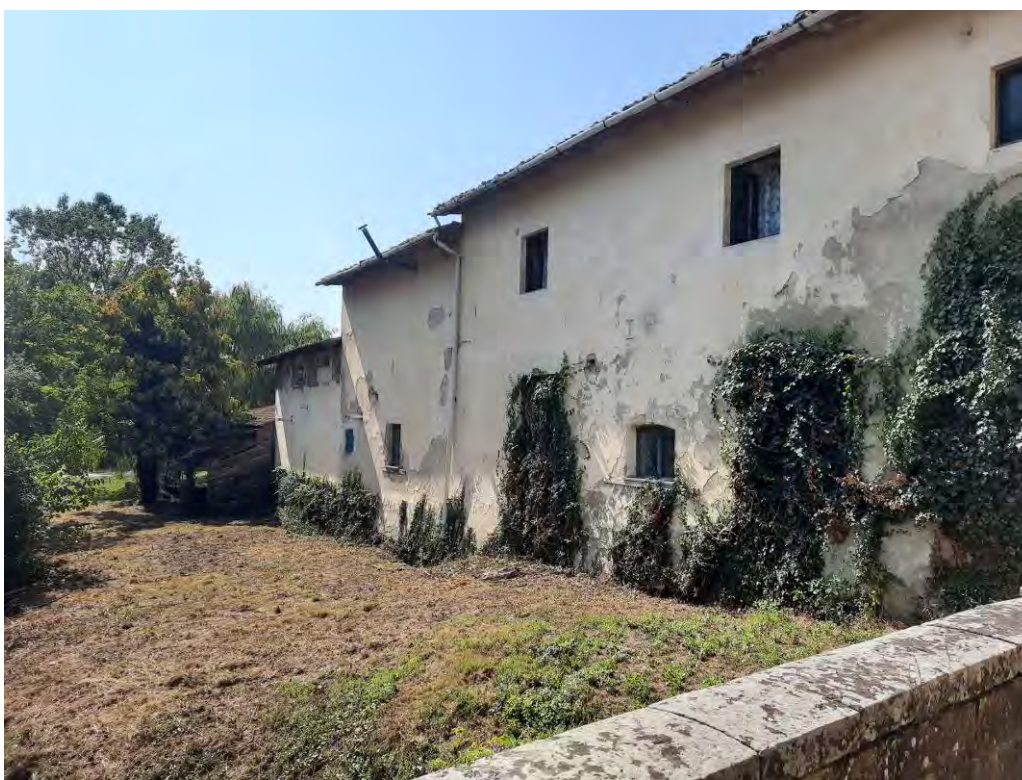
FOTO 11 – Prospetto retrostante del fabbricato 'A'
