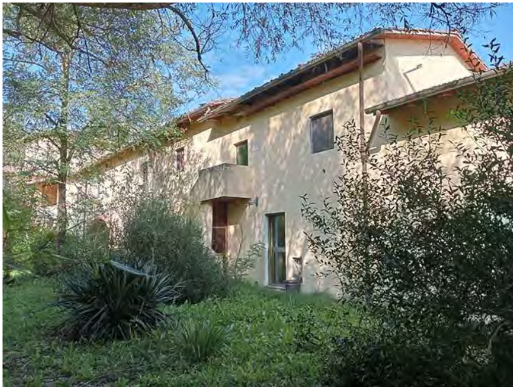
FOTO 37 – locali a piano terra a destinazione magazzino indipendenti dagli appartamenti 1 e 2
