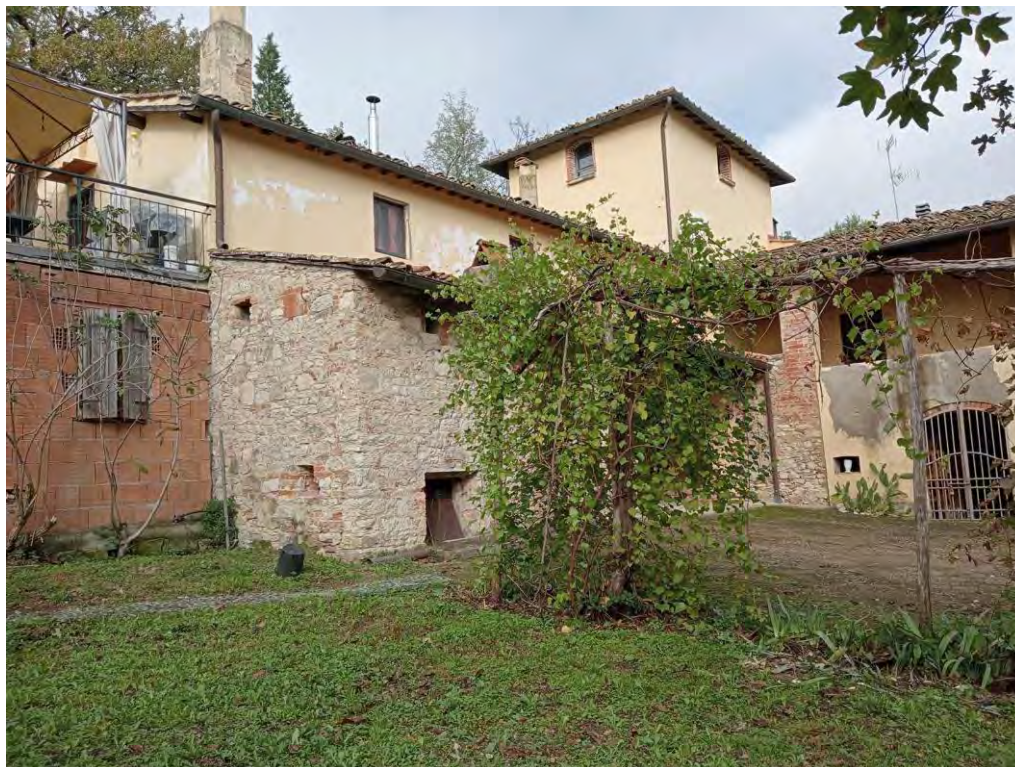
FOTO 7 – Il fabbricato principale 'A' con vista della torretta e del nucleo originario molto antico risalente al 1600.
