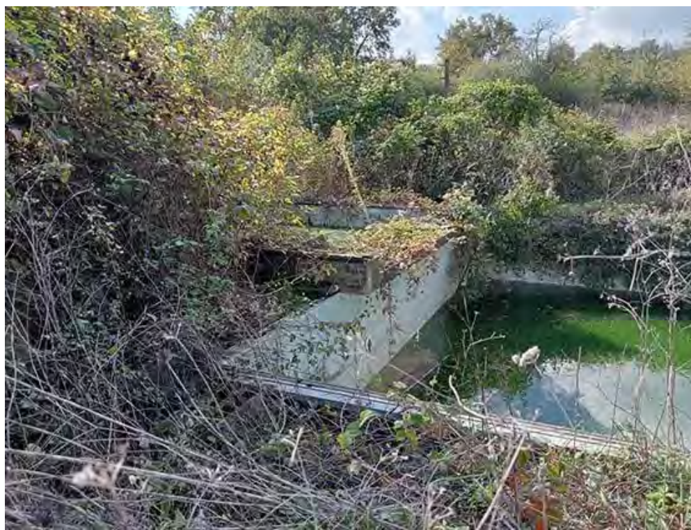
FOTO 54 – Altra immagine in prossimità del vano tecnico
