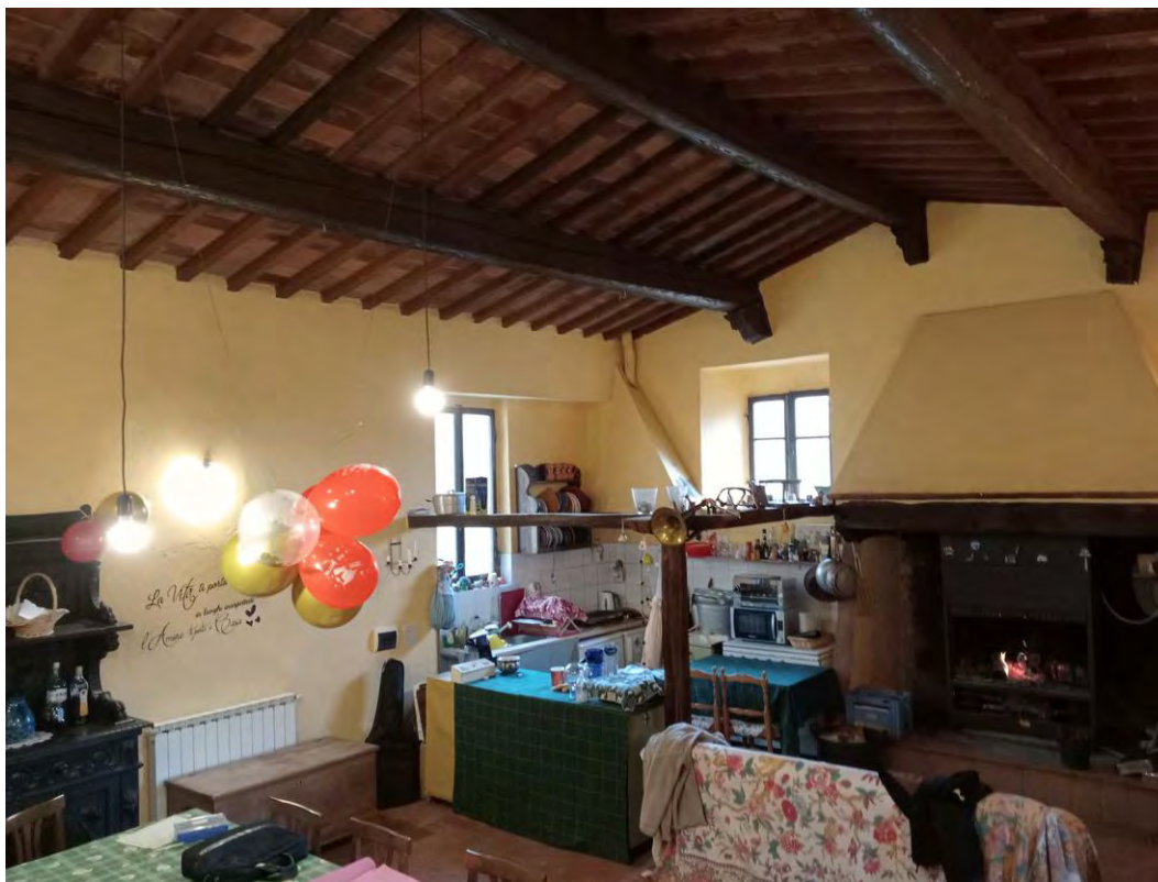
FOTO 13 – Immagine della cucina/soggiorno, parte più antica dell' edificio con camino e soffitto a capriate lignee.
