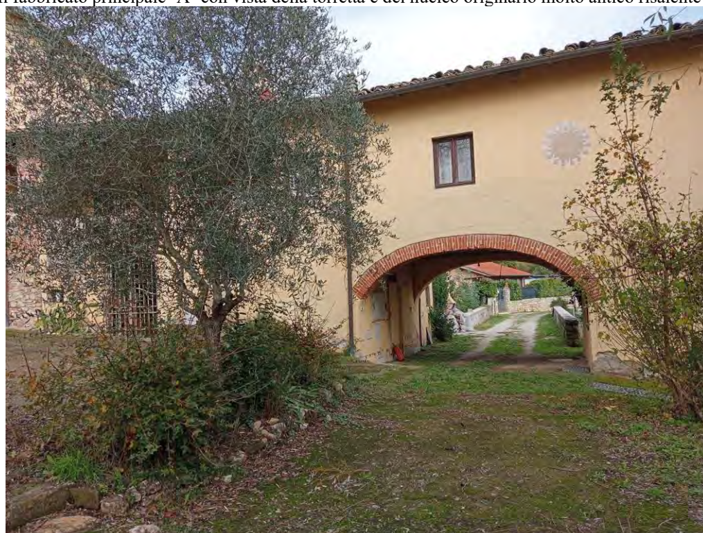
FOTO 8 – Porzione del prospetto principale con sottopasso ad arco ribassato per il collegamento con il fosso "Delle formiche".
