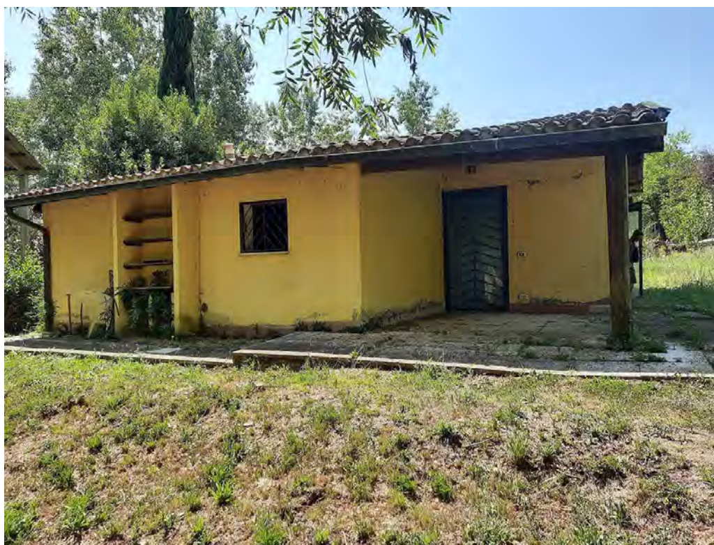
FOTO 42 – Fabbricato indipendente originariamente annesso agricolo, oggi adibito impropriamente ad uso abitazione
