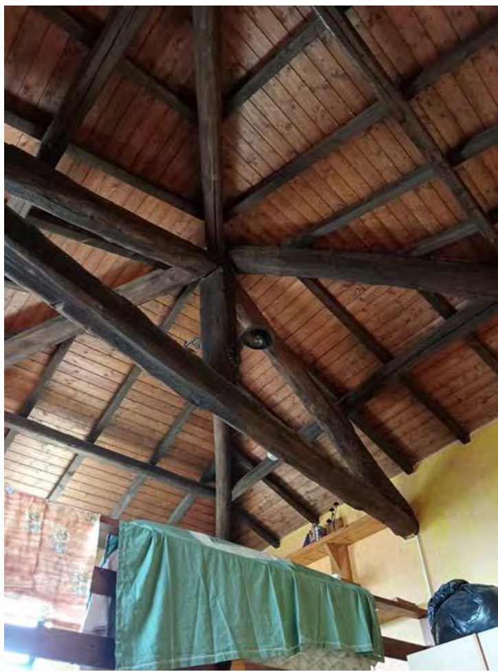
FOTO 18 – La copertura a padiglione della torretta con travi e capriate lignee a vista
