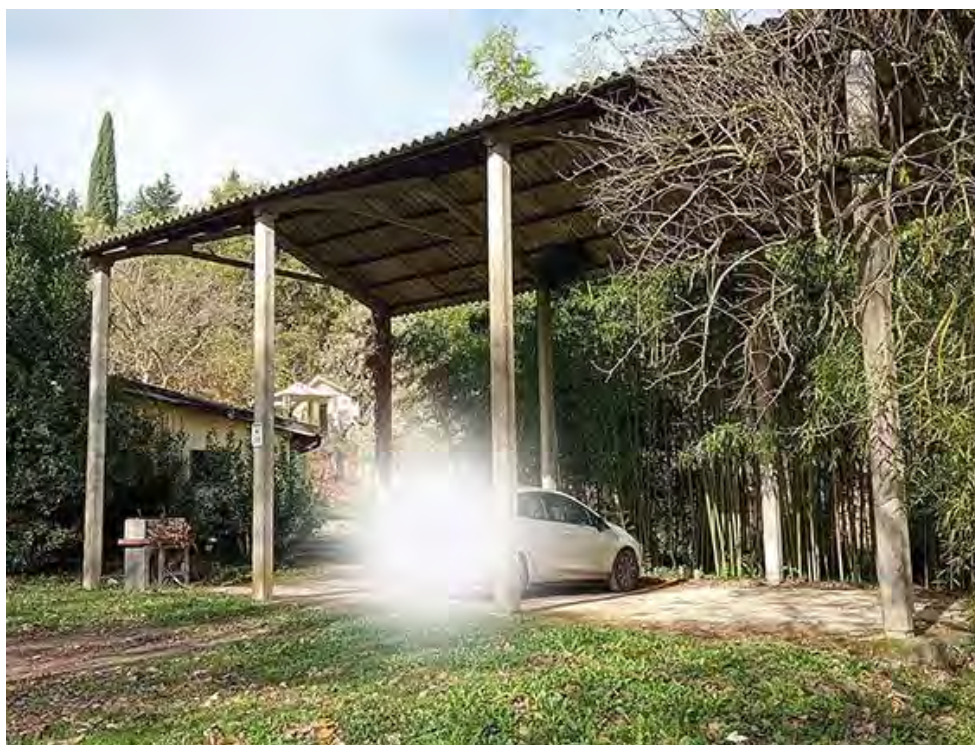
FOTO 47 – Tettoia per rimessa macchine e attrezzi
