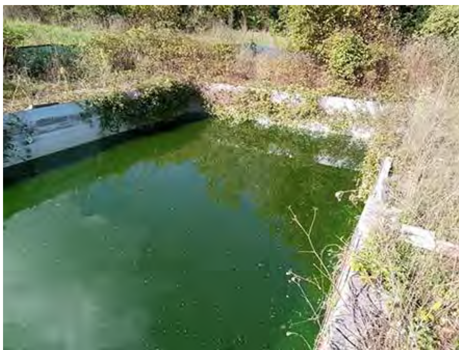
FOTO 52 – Piscina. L'impianto non è attivo come si deduce dall' acqua stagnante
