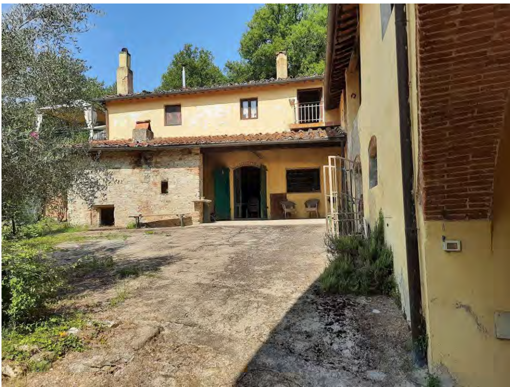
FOTO 27 – Prospetto principale con inquadramento dell'appartamento n. 2 al p1 e locali accessori di pertinenza al pt
