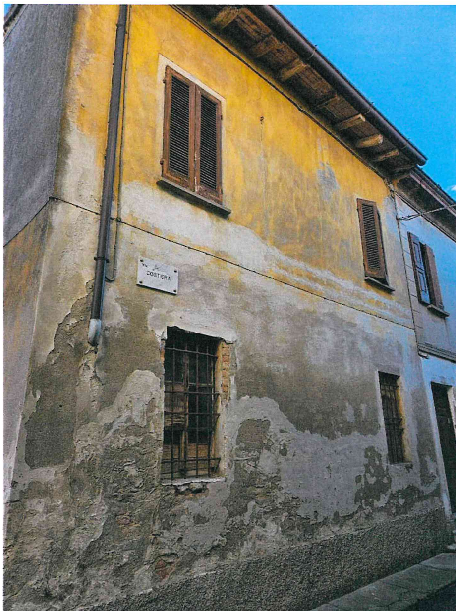
VISTA DEL PROSPETTO DA VIA SILVIO PELLICO ANGOLO VIA COSTIERA
