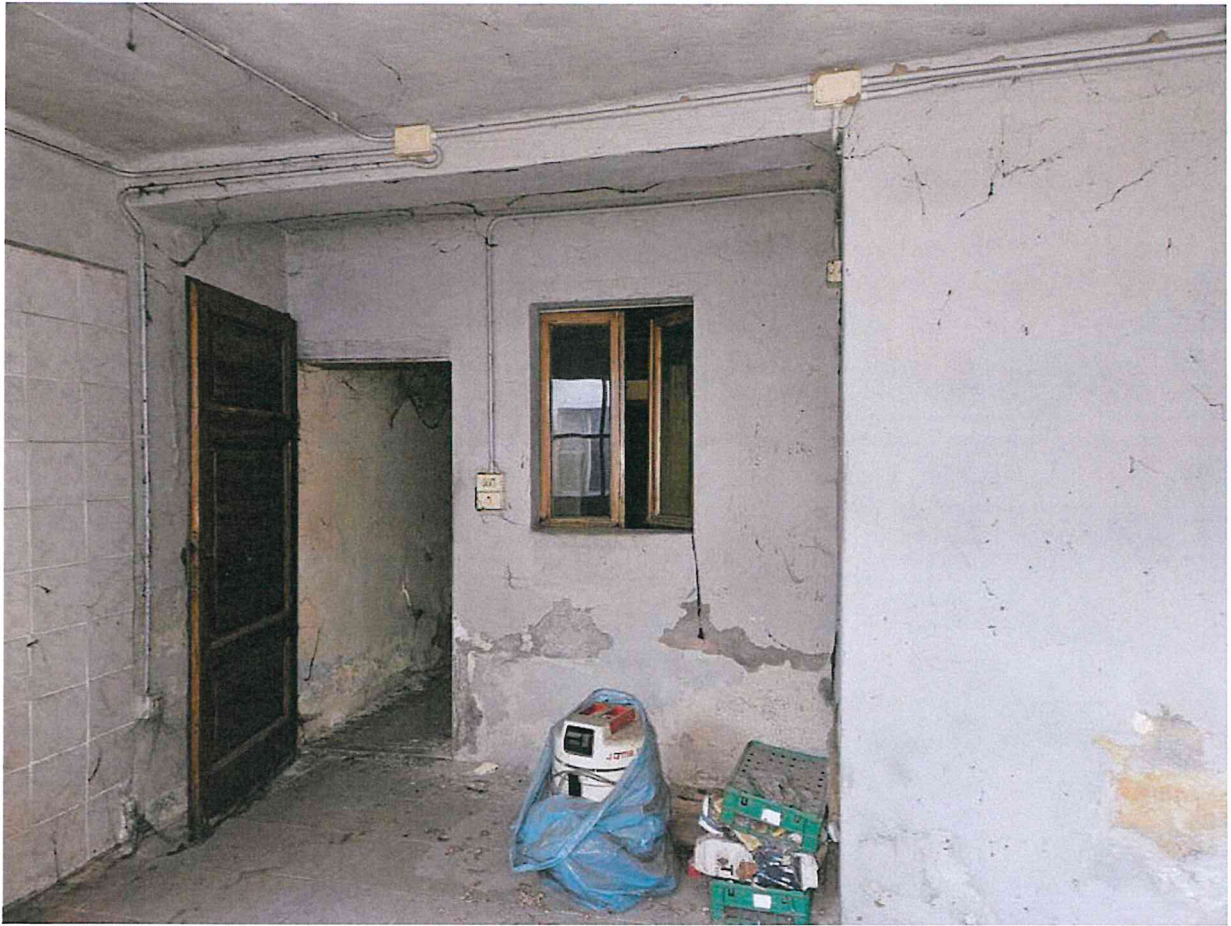
VISTA DEI LOCALI A PIANO TERRA DALLA VERANDA
