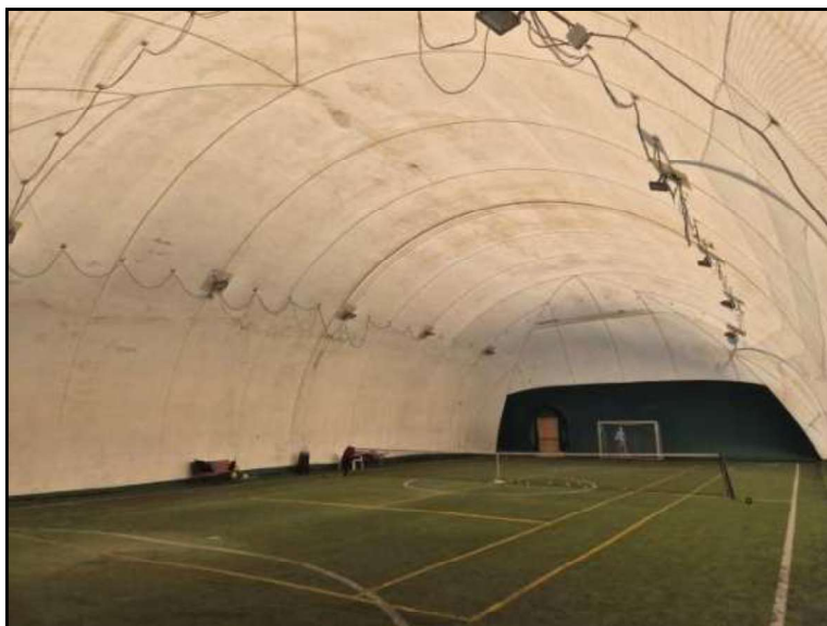
FOTO 13 VISTA INTERNA CAMPO MULTIUSO CALCETTO/TENNIS CON COPERTURA PRESSOSTATICA NON AUTORIZZATA E DA RIMUOVERE.
