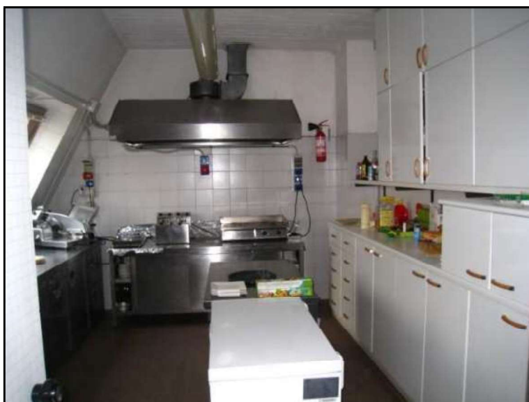
FOTO 54 PIANO PRIMO ALTRA VISTA CUCINA AL SERVIZIO DEL BAR.
