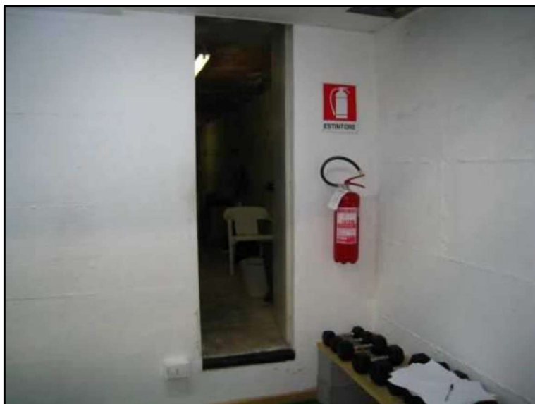
FOTO 71 PIANO INTERRATO VISTA RIPRESA VERSO PORTA DI COLLEGAMENTO CON INTERCAPEDINE.
