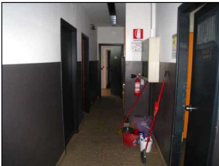
FOTO 24 PIANO TERRA VISTA DISIMPEGNO ZONA SPOGLIATOI E SERVIZI.
