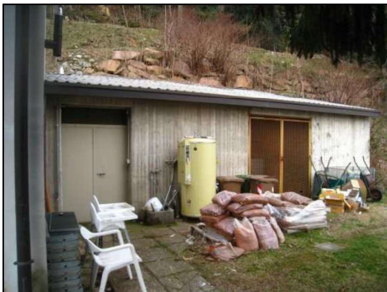
FOTO 2 VISTA RIPRESA SUL LATO SUD VERSO LA PORZIONE DESTINATA A MAGAZZINI.
