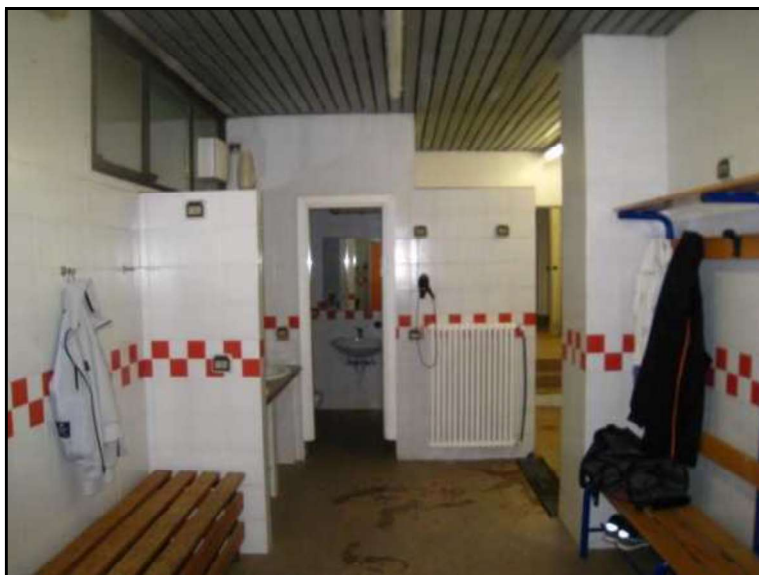
FOTO 37 PIANO TERRA ALTRA VISTA SPOGLIATOIO DELLA FOTO PRECEDENTE.
