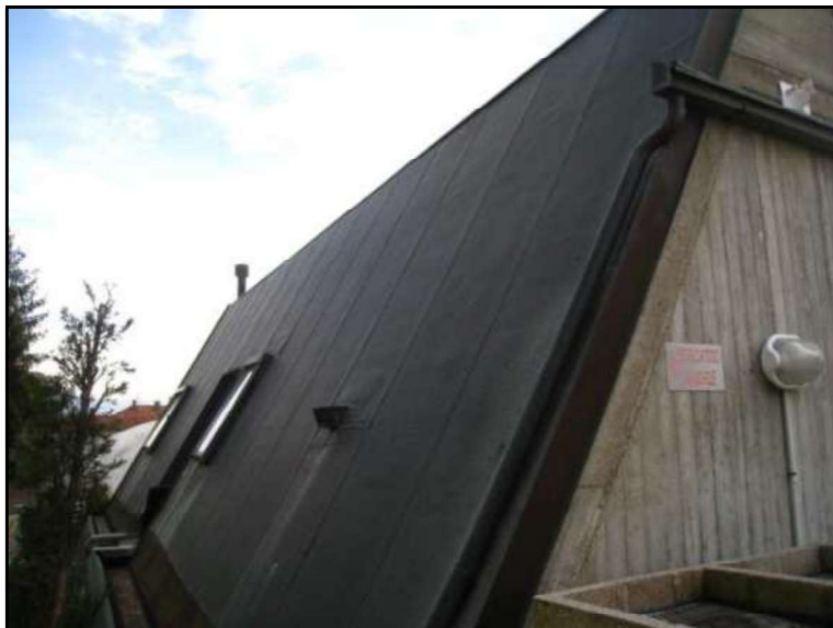
FOTO 10 ALTRA VISTA DEL FABBRICATO "A" SUL LATO NORD.
