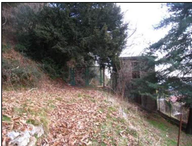
FOTO 3 VISTA RIPRESA VERSO ALTRO CANCELLO SUL LATO EST (SULLO SFONDO) DI SERVIZIO AL COMPENDIO.
