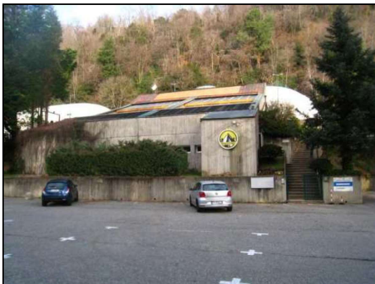
FOTO 1 VISTA DEL COMPENDIO OGGETTO DI PROCEDURA ESECUTIVA RIPRESO DALL'AREA A PARCHEGGIO.
