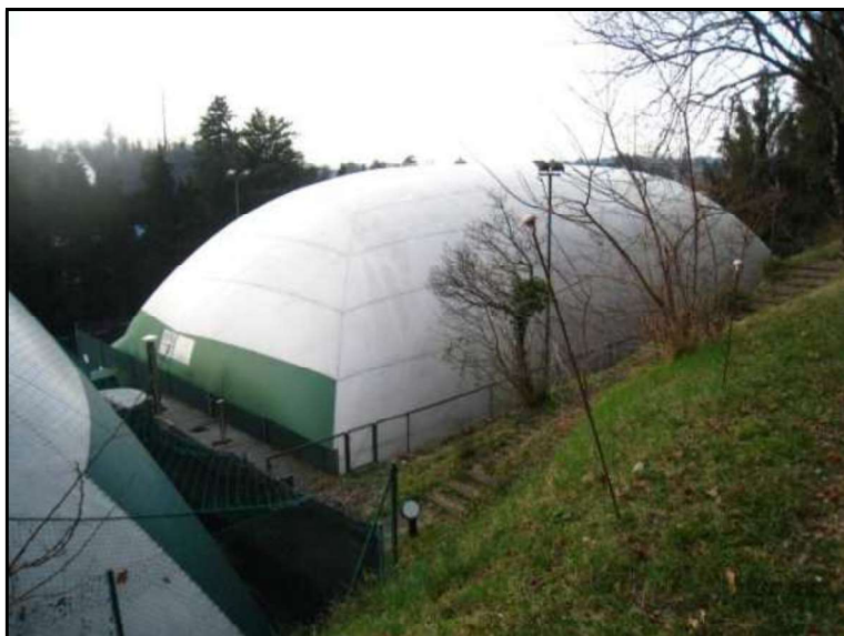
FOTO 14 VISTA CAMPO DA TENNIS CON COPERTURA PRESSOSTATICA AUTORIZZATA E DA RIMUOVERE.
