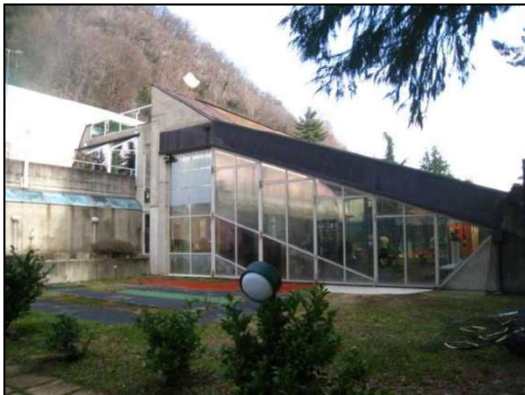
FOTO 14 ALTRA VISTA DEL FABBRICATO "A" SUL LATO OVEST.
