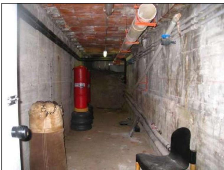
FOTO 75 PIANO INTERRATO VISTA INTERNA ALTRA INTERCAPEDINE.
