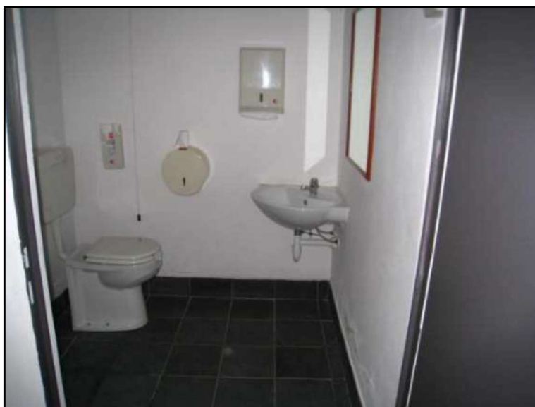
FOTO 15 VISTA W.C. AL SERVIZIO DELLO SPOGLIATOIO DELLA FOTO PRECEDENTE.
