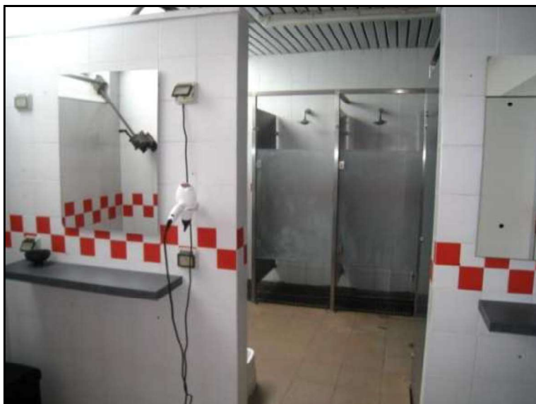
FOTO 29 PIANO TERRA ALTRA VISTA RIPRESA NELLO SPOGLIATOIO. SULLO SFONDO LE DOCCE.
