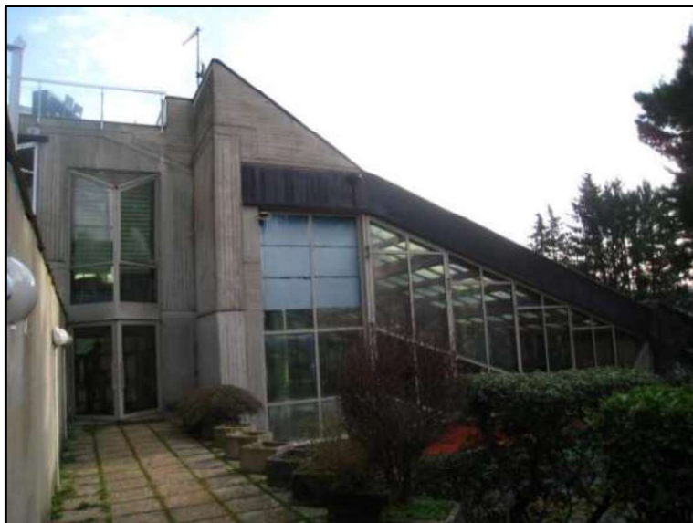
FOTO 13 ALTRA VISTA DEL FABBRICATO "A" SUL LATO OVEST.
