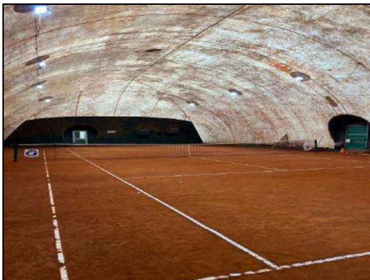
FOTO 10 VISTA INTERNA DEL CAMPO DA TENNIS DELLA FOTO PRECEDENTE.
