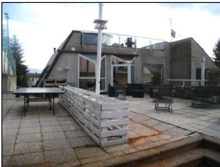
FOTO 12 VISTA DEL FABBRICATO "A" SUL LATO OVEST.
