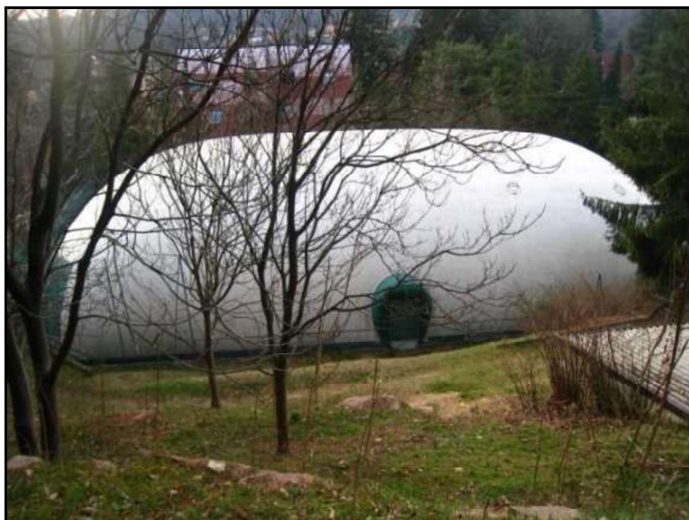
FOTO 8 VISTA CAMPO DA TENNIS CON COPERTURA PRESSOSTATICA AUTORIZZATA FATTA REALIZZARE DALLA CONDUTTRICE.
