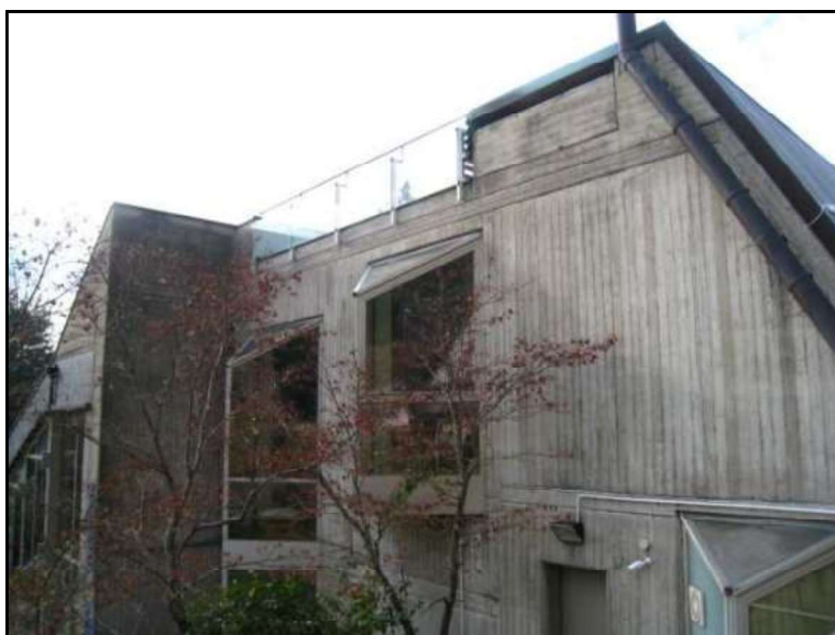
FOTO 6 ALTRA VISTA DEL FABBRICATO "A" SUL LATO EST.
