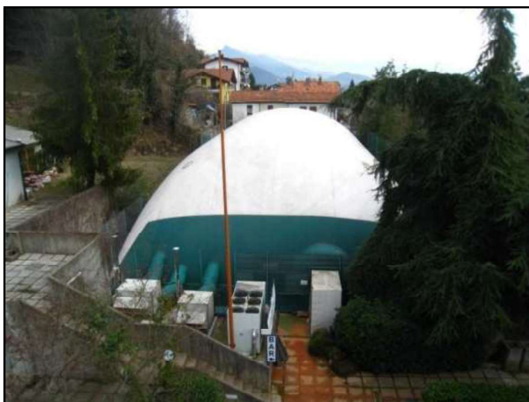
FOTO 9 ALTRA VISTA CAMPO DA TENNIS CON COPERTURA PRESSOSTATICA AUTORIZZATA FATTA REALIZZARE DALLA CONDUTTRICE.
