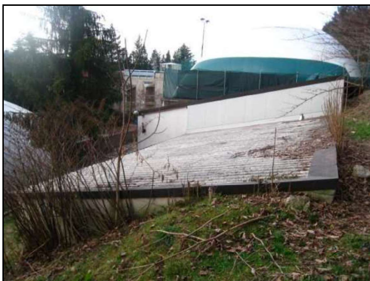
FOTO 3 VISTA RIPRESA VERSO LA COPERTURA DELLA PORZIONE DESTINATA A MAGAZZINI
