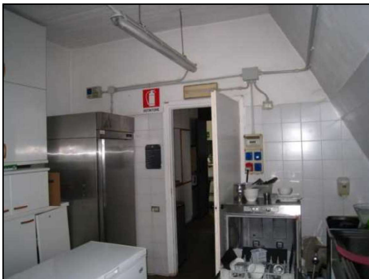
FOTO 56 PIANO PRIMO ALTRA VISTA CUCINA AL SERVIZIO DEL BAR.
