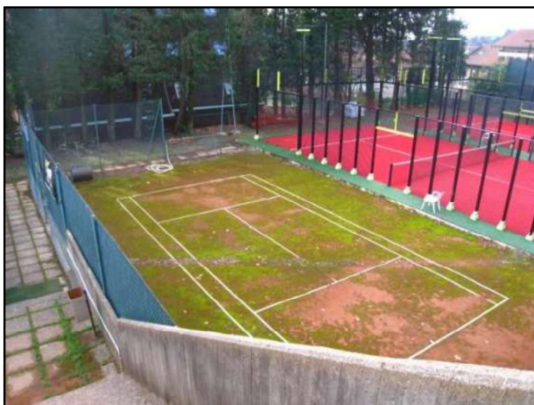
FOTO 18 VISTA CAMPO DA TENNIS IN DISUSO NON AGIBILE SUL LATO OVEST DEL FABBRICATO "A".
