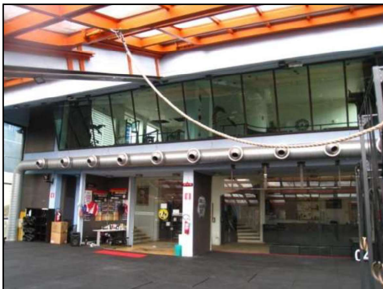
FOTO 19 PIANO TERRA ALTRA VISTA RIPRESA NELLA PALESTRA.
