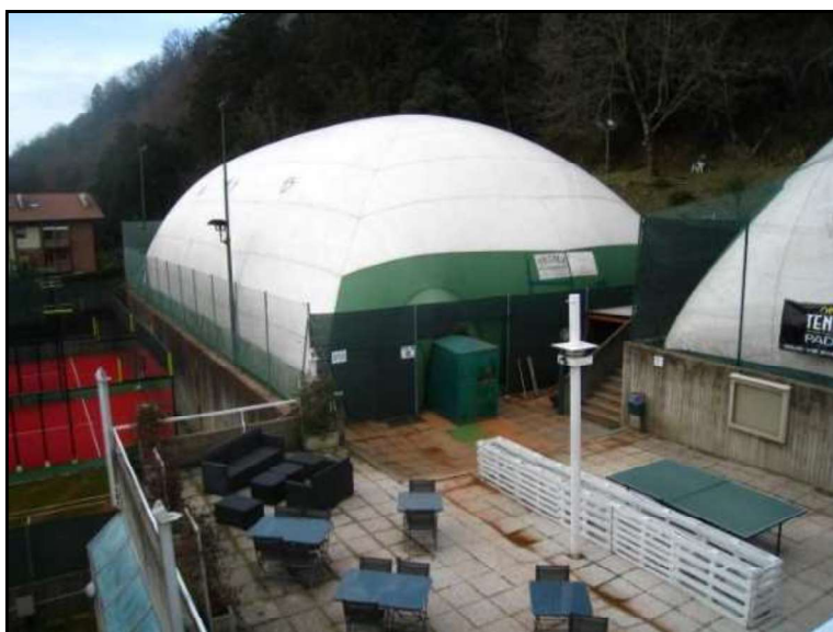
FOTO 15 ALTRA VISTA CAMPO DA TENNIS CON COPERTURA PRESSOSTATICA NON AUTORIZZATA E DA RIMUOVERE.
