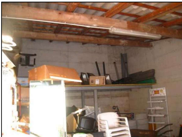
FOTO 23 VISTA ALTRO MAGAZZINO OVE È PRESENTE SOPPALCO.
