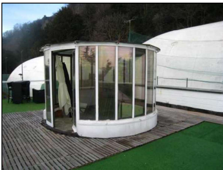
FOTO 63 PIANO SECONDO VISTA USCITA ARRIVO SCALA SUL TERRAZZO.
