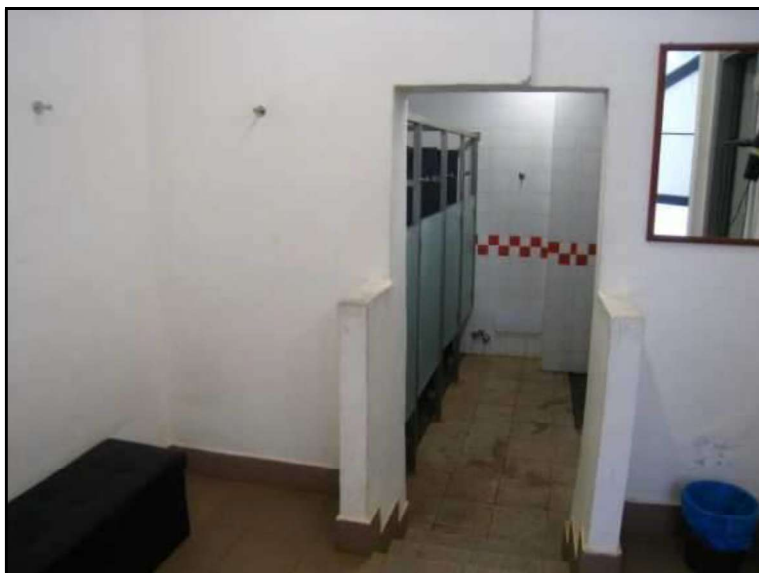
FOTO 44 PIANO TERRA ALTRA VISTA RIPRESA ZONA SPOGLIATOI DELLA FOTO PRECEDENTE.
