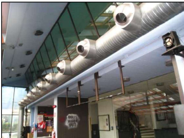
FOTO 20 PIANO TERRA ALTRA VISTA RIPRESA NELLA PALESTRA.
