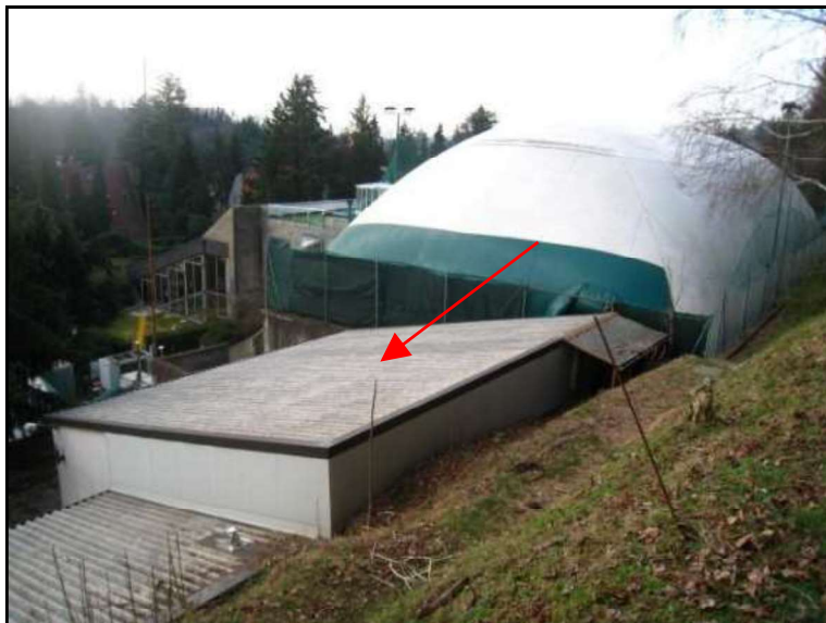
FOTO 4 VISTA RIPRESA VERSO LA COPERTURA DELLA PORZIONE DESTINATA A PALESTRA E SERVIZI (INDICATA DALLA FRECCIA ROSSA).
