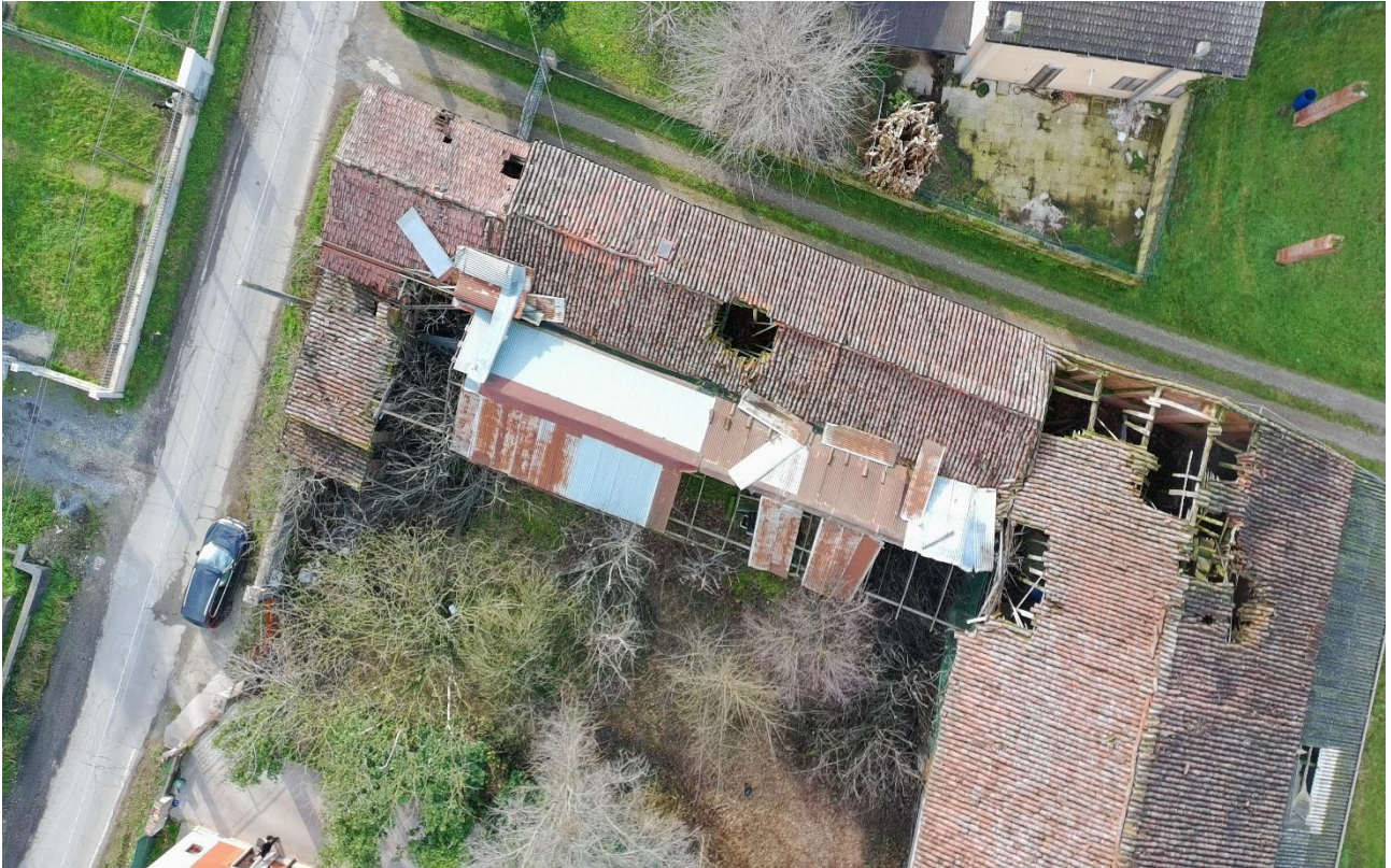
Vista aerea copertura fienile e tettoie
