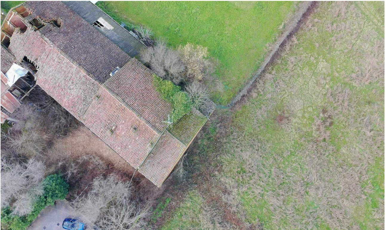
Vista aerea copertura abitazione
