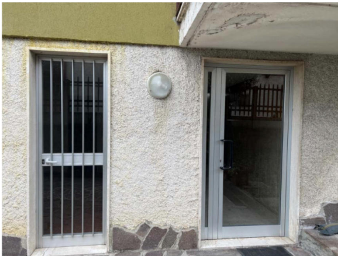
INGRESSO AL VANO SCALA COMUNE DAL CORTILE
