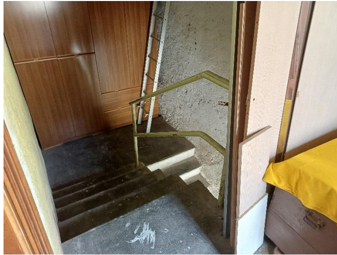
Foto 34 – Inizio scala di accesso al piano cantine
