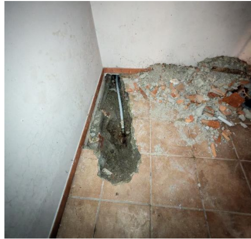
Immagini 29 e 30: fotografia di un vano al piano interrato (le finestre affacciano su un'intercapedine) e dell'apertura a pavimento effettuata per l'intervento sulle tubazioni.
