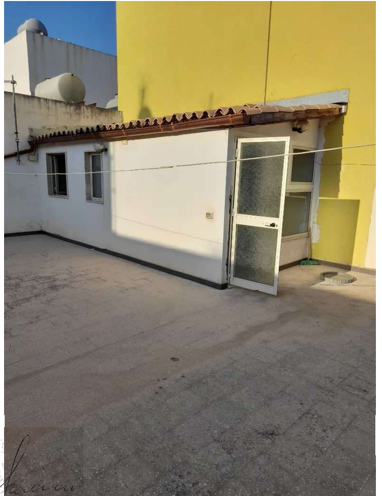
Foto n°12 - Vista esterna del primo piano
