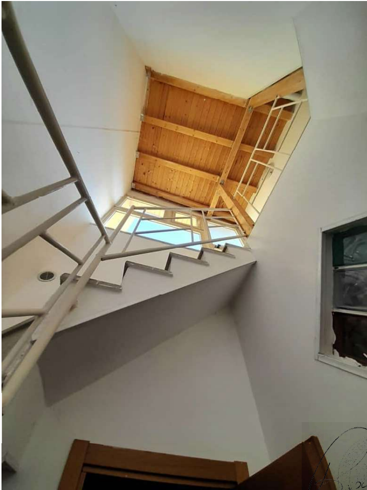
Foto n°11 - Vista interna del pozzo luce
