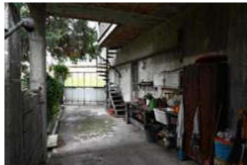
Corte esterna verso sud
