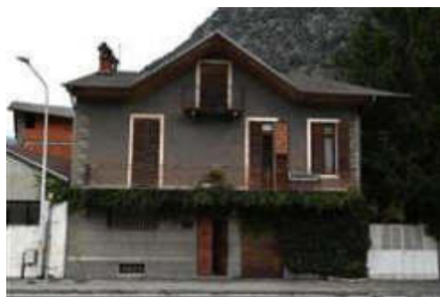
Fronte sud del fabbricato principale.
