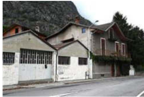
Ripresa da sud ovest del complesso.
