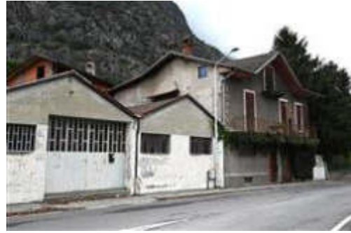
Ripresa da sud ovest del complesso.
