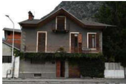
Fronte sud del fabbricato principale.
