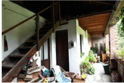
loggiato, vista verso nord. scala in legno di accesso al sottotetto.
