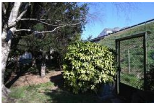
Recinzione di confine e ciglio autostradale
