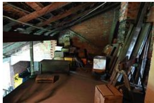
Sottoetto verso loggiato: senza parapetto.
