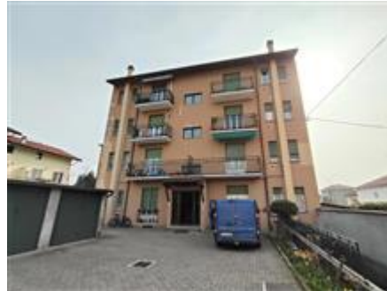
Particolare esterno edificio
