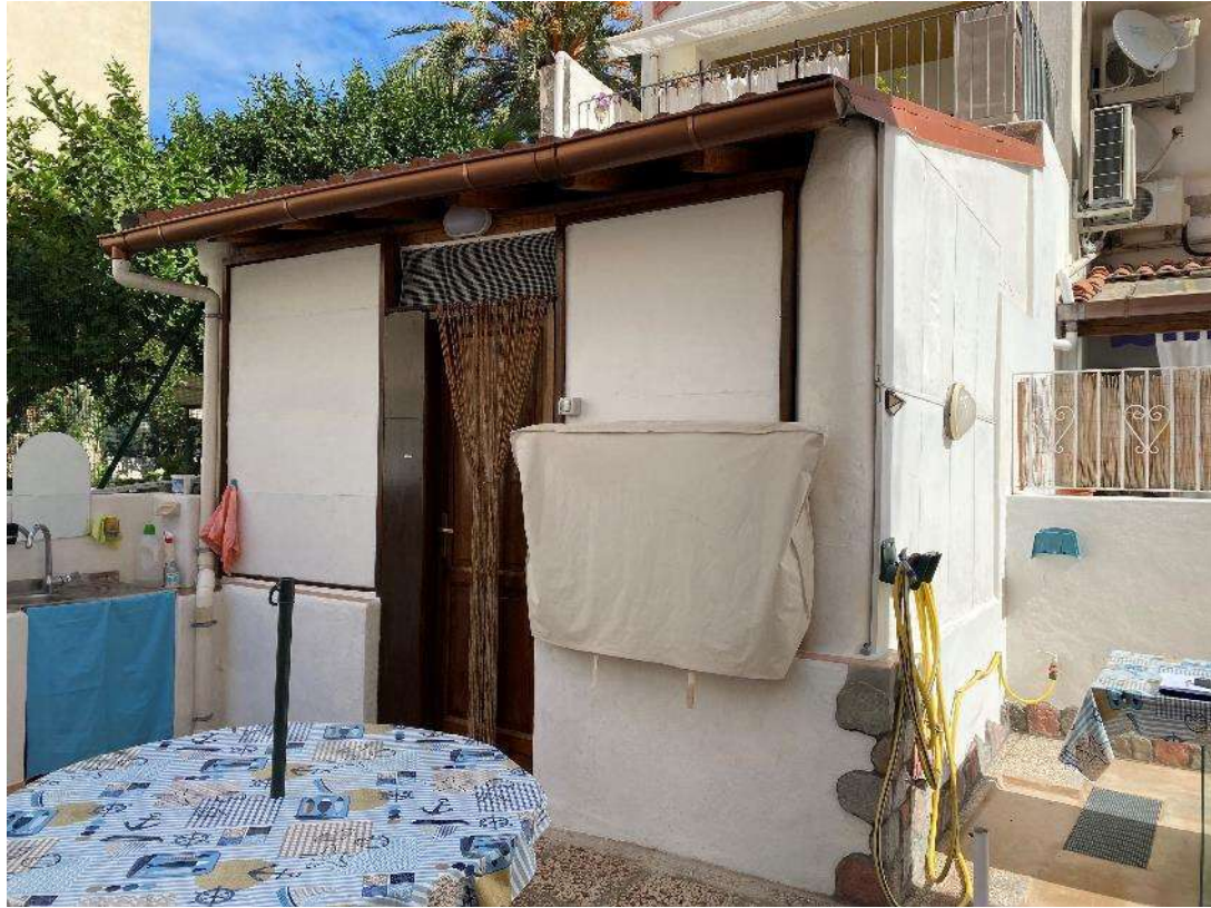
Foto 13_ Locale Deposito_ ex parcheggio scoperto
