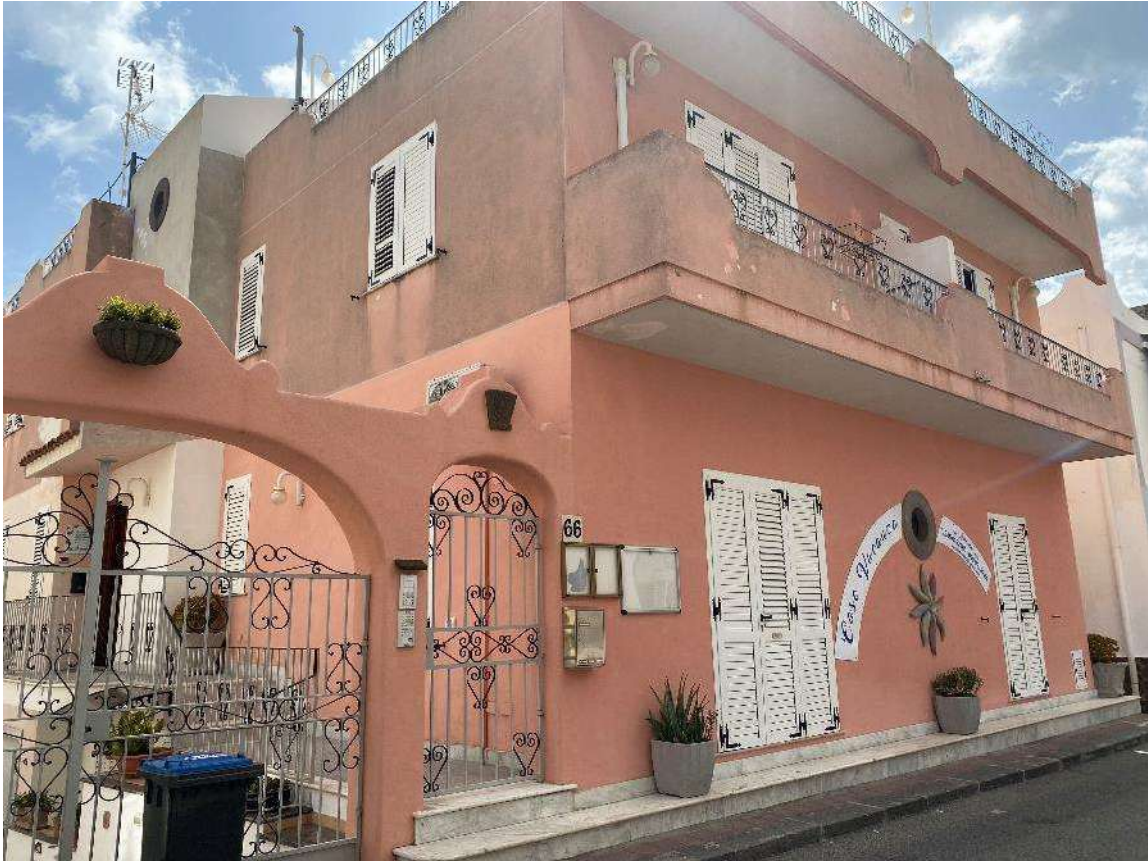
Foto 1_ Immobile oggetto di esecuzione Ingresso Via Cesare Battisti
