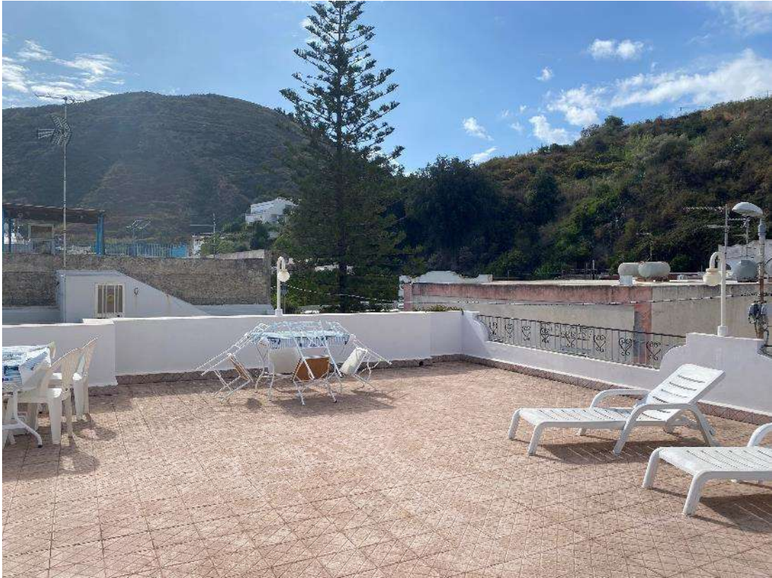
Foto 58_ Terrazza vista monte
