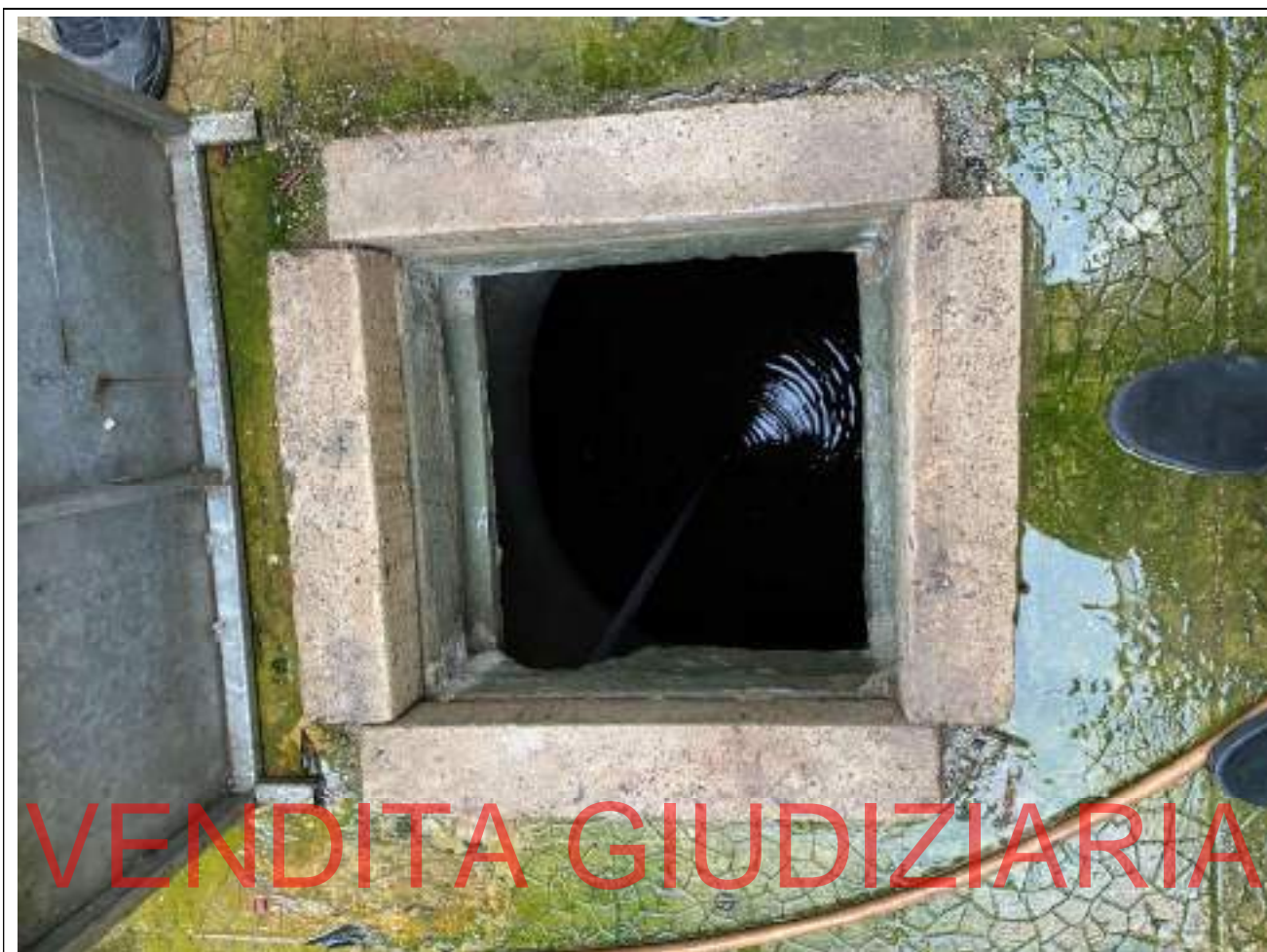
Foto 13: CISTERNA IN COMUNIONE CON IL SUB. 3 (APPARTAMENTO)
