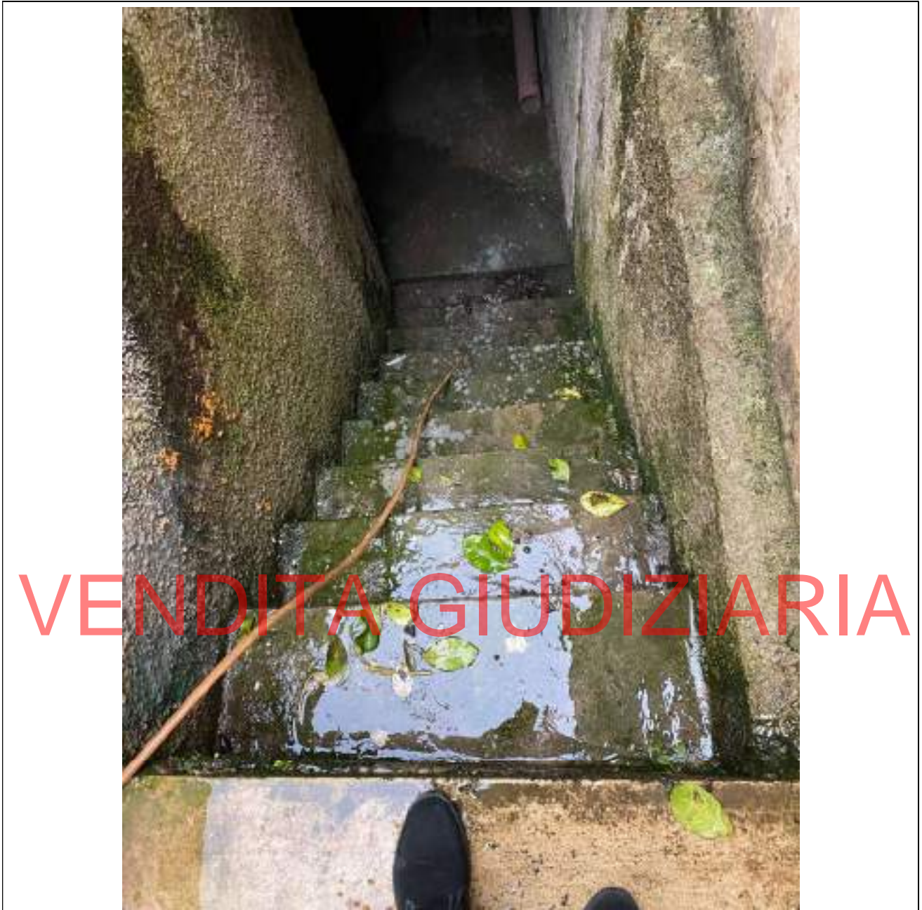
Foto 15: LOCALE INTERRATO DA ASSEGNARE AL LOTTO 2
