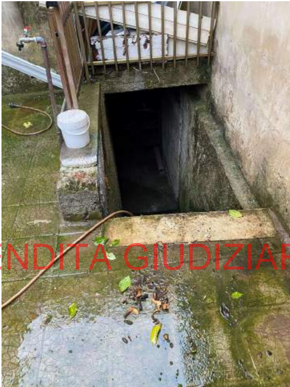
Foto 14: LOCALE INTERRATO DA ASSEGNARE AL LOTTO 2
