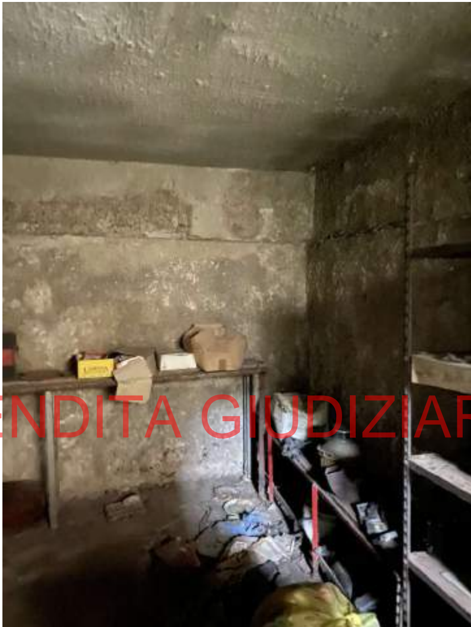
Foto 16: LOCALE INTERRATO DA ASSEGNARE AL LOTTO 2
