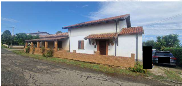
foto 1 – Vista prospettica fabbricato lato SUD
