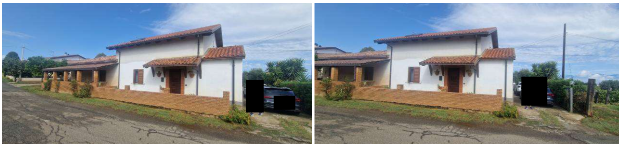
foto 1 e foto 2 – Vista prospettica fabbricato lato SUD
