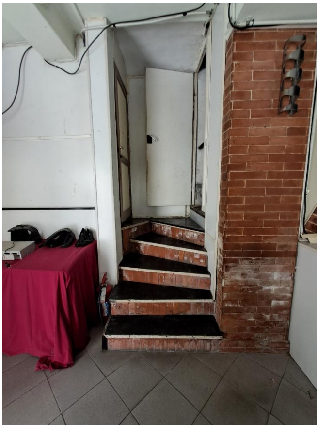
INGRESSO – SCALA E WC
