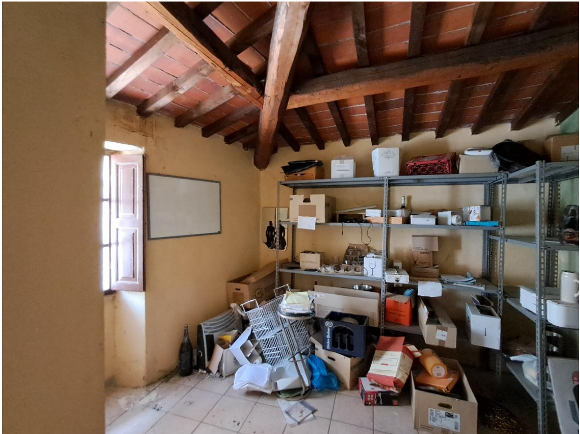
LOCALE AL PRIMO PIANO CON COPERTURA IN LEGNO
