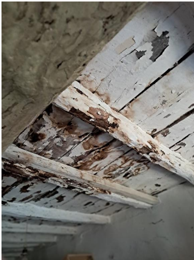
PARTICOLARE SOFFITTO IN LEGNO
