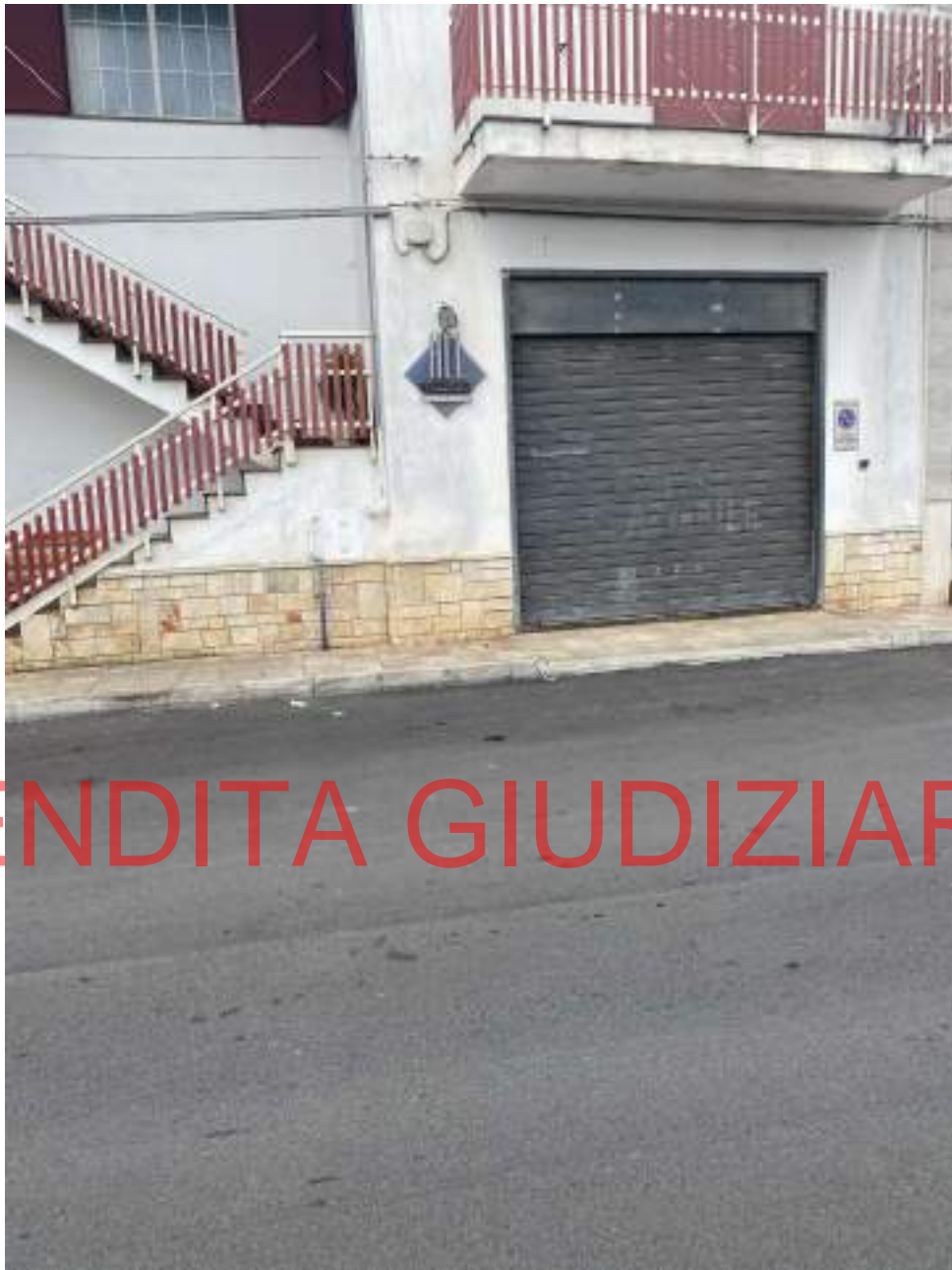
Foto 15: PROSPETTO PRINCIPALE LOCALE GARAGE
