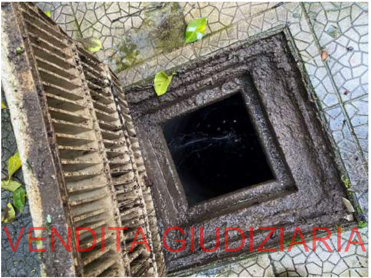
Foto 13: POZZO NERO IN COMUNIONE CON IL SUB. 1 (LOCALE ARTIGIANALE)
