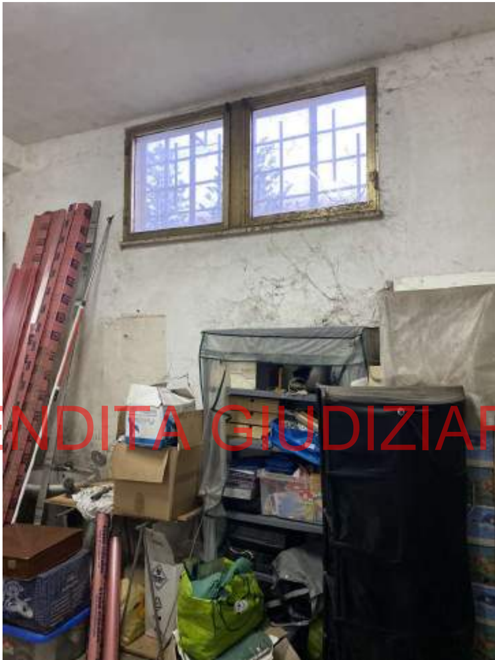
Foto 20: INTERNO LOCALE GARAGE
