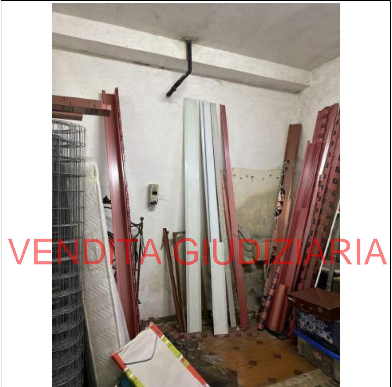
Foto 19: INTERNO LOCALE GARAGE
