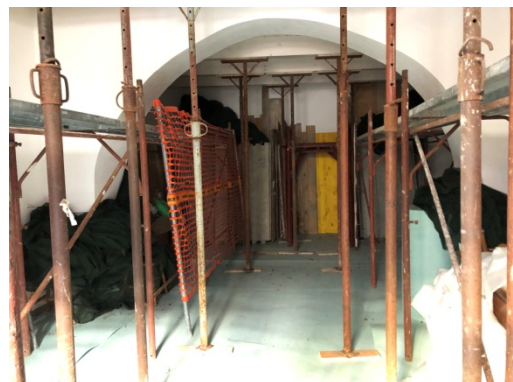
Fig. 42 p.lla 410 sub 1 – VISTA INTERNA
