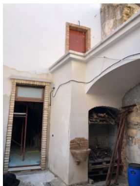
Fig. 42 p.lla 410 sub 1 – ACCESSO
