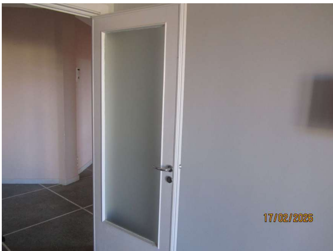
FOTO 12 Un dettaglio delle porte interne: originali anni '50 restaurate piuttosto bene e in ottime condizioni.
