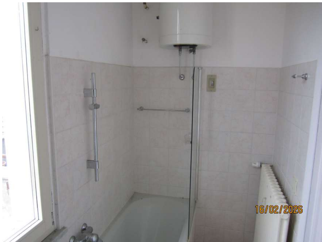
FOTO 15 Altro scorcio del bagno, lato vasca. Visibile il boiler elettrico per la produzione dell'acqua calda sanitaria
