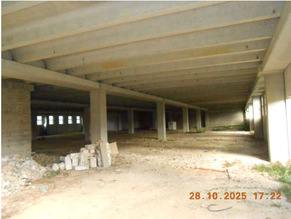
Foto n. 24 Piano seminterrato – Vano da completare
