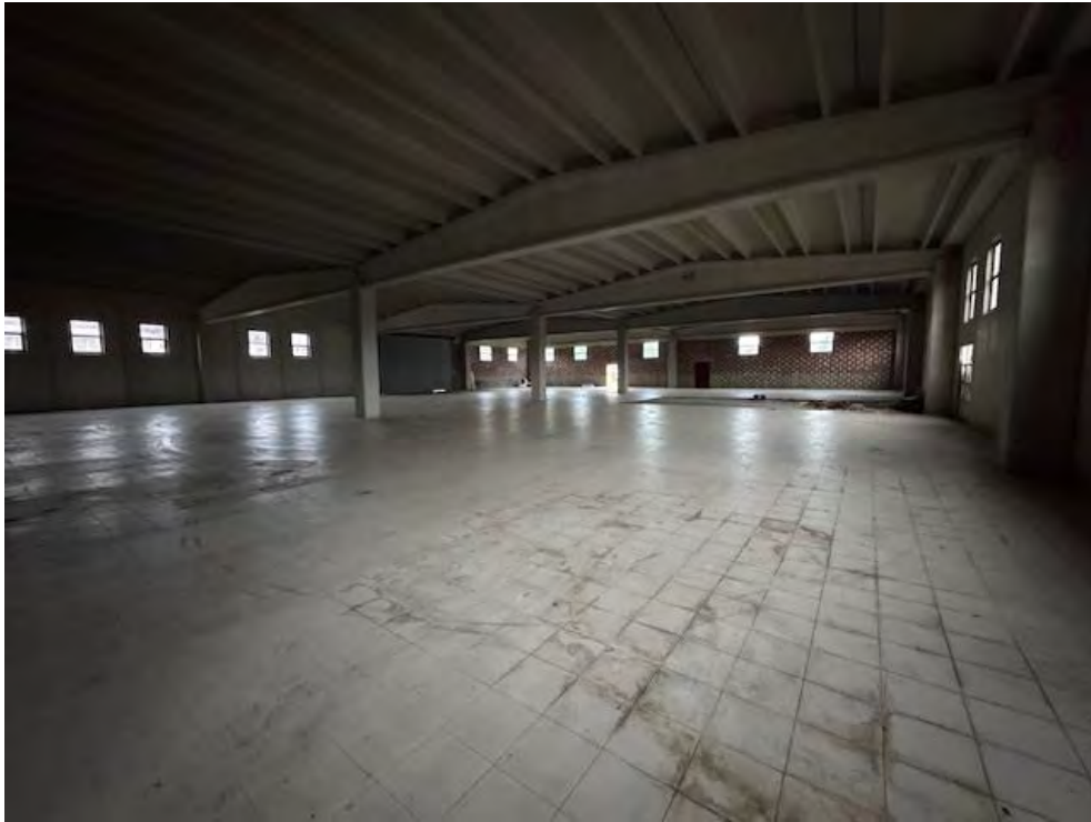
Foto n. 11 Piano terra – Vano 1
