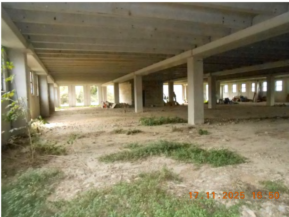
Foto n. 23 Piano seminterrato – Vano da completare
