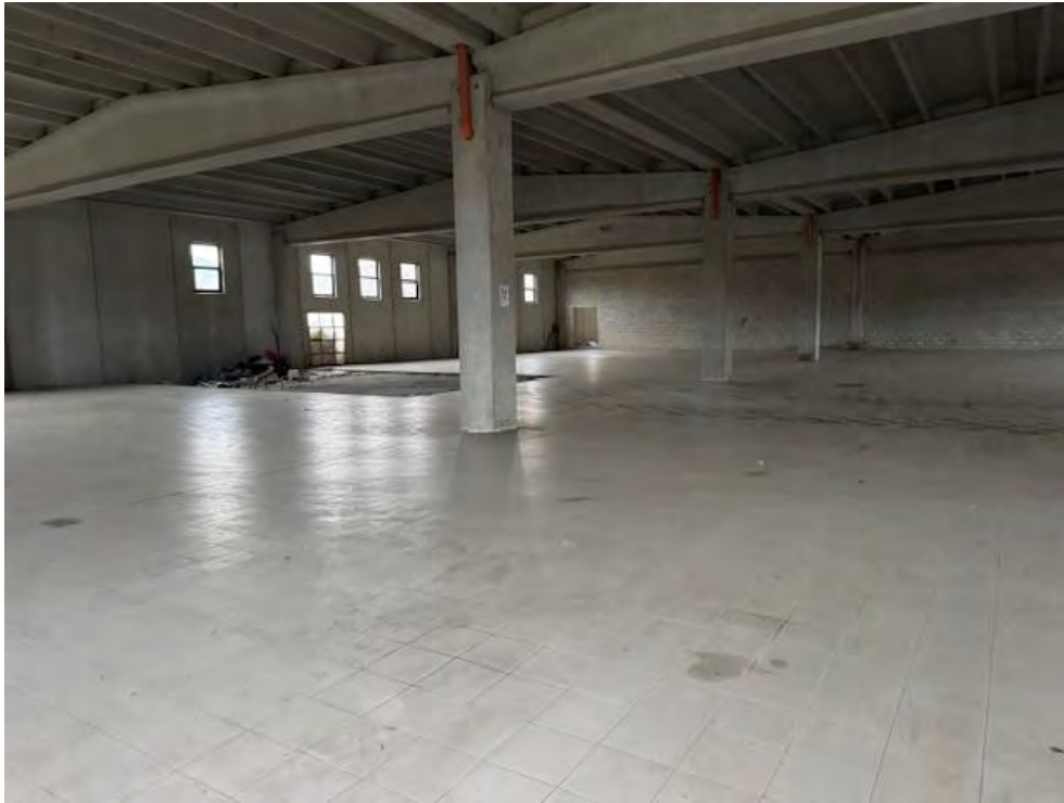
Foto n. 13 Piano terra – Vano 1
