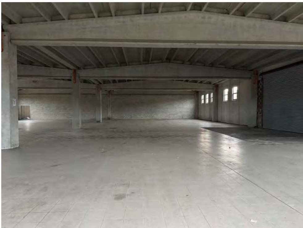
Foto n. 12 Piano terra – Vano 1
