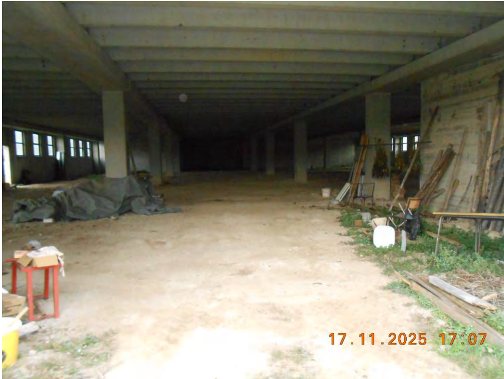
Foto n. 22 Piano seminterrato – Vano da completare
