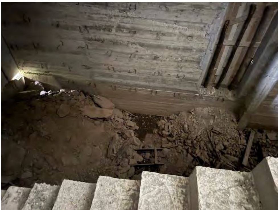
Foto n. 20 Piano terra – Vano scala
