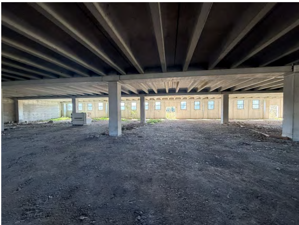
Foto n. 25 Piano seminterrato – Vano da completare
