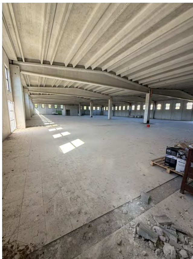
Foto n. 16 Piano terra – Vano 2
