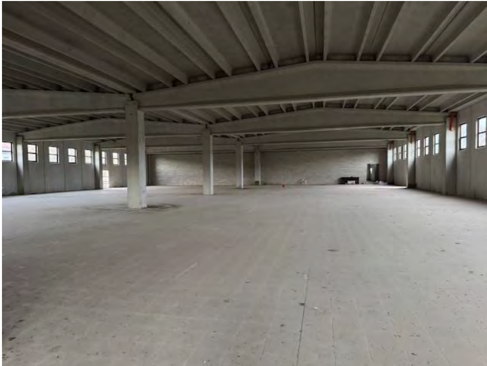
Foto n. 15 Piano terra – Vano 2
