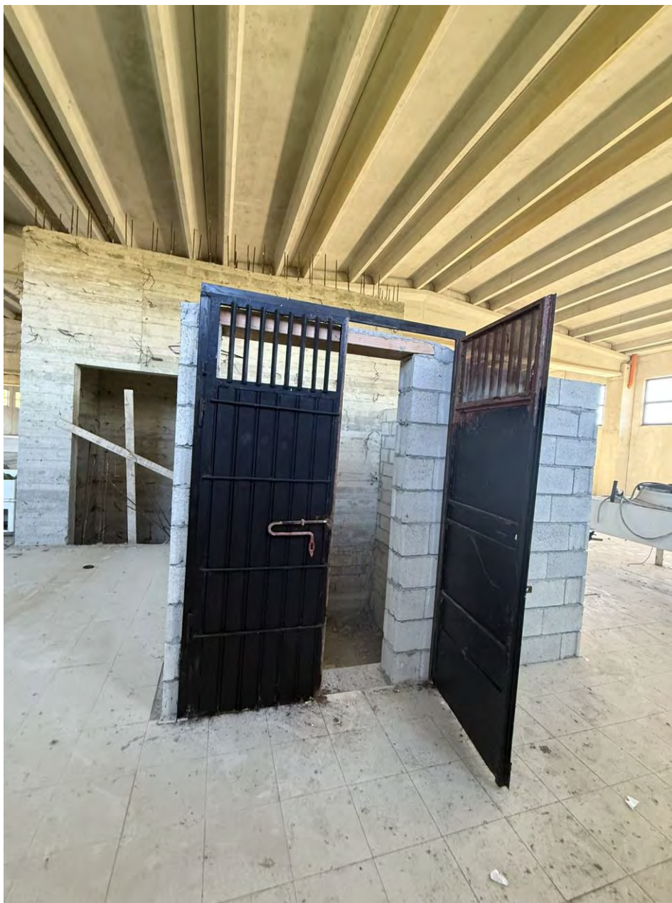
Foto n. 19 Piano terra – Vano scala
