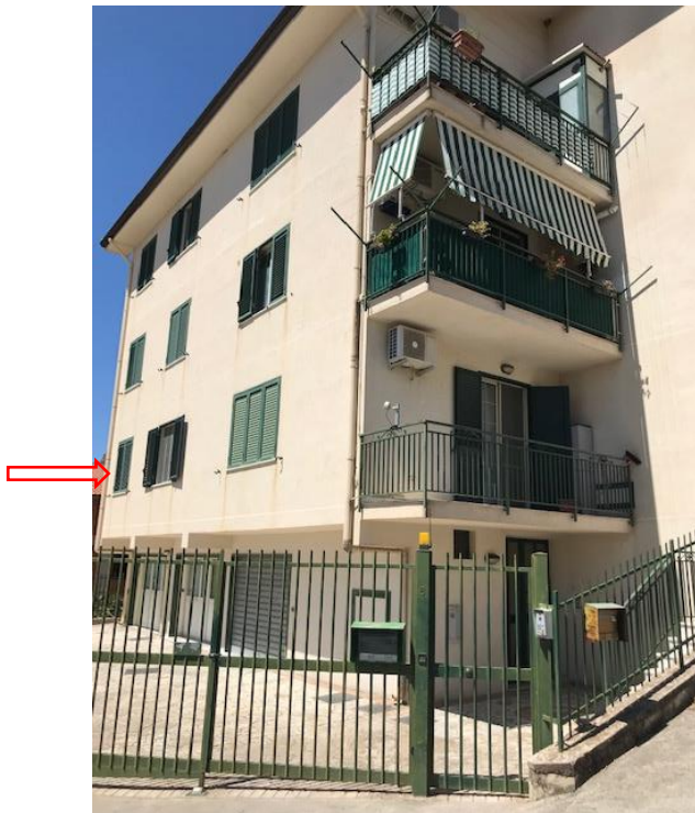
FOTO 2) CANCELLO DI INGRESSO
