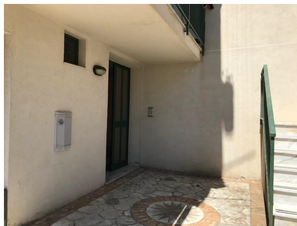
FOTO 3) PORTONE DI INGRESSO CONDOMINIALE
