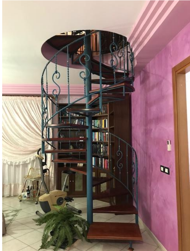
11) SCALA IN FERRO CON FORO NEL SOLAIO CHE COL- APPARTAMENTO DI 1° PIANO CON QUELLO A 2° PIANO
