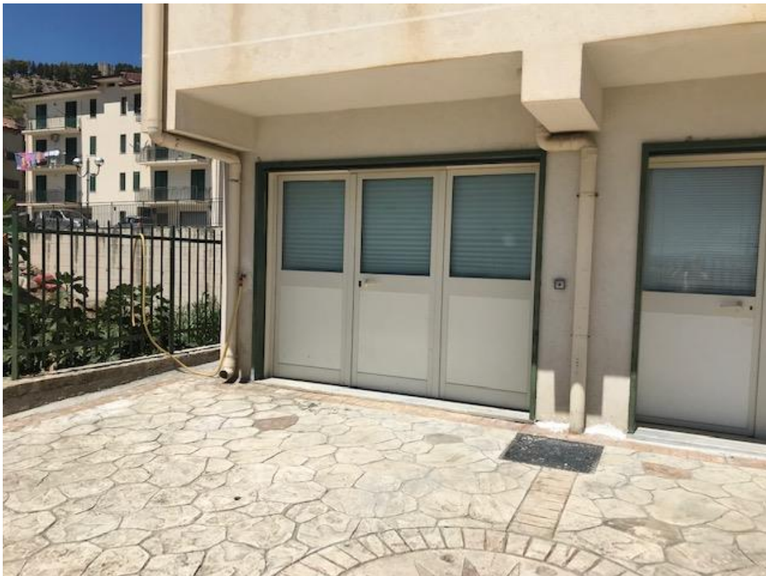
FOTO 4) INGRESSO DEL GARAGE
