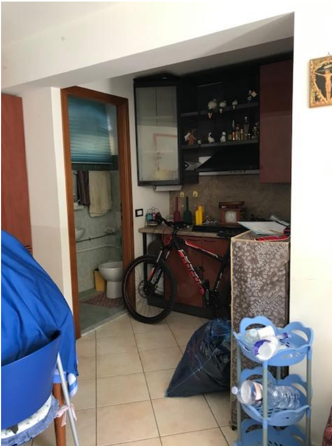
FOTO 6) INTERNO CON PORZIONE DEL LOCALE ATTIGUO ACCORPATA AL GARAGE
