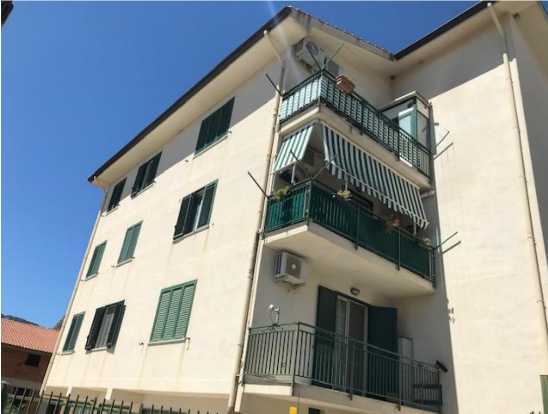
FOTO 4) PALAZZINA PROSPETTO NORD-EST
