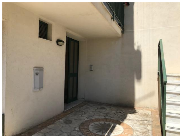
FOTO 3) PORTONE DI INGRESSO CONDOMINIALE
