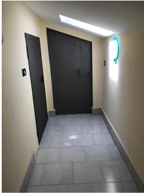
8) PORTA DI INGRESSO AL LOCALE SOTTO- TETTO
