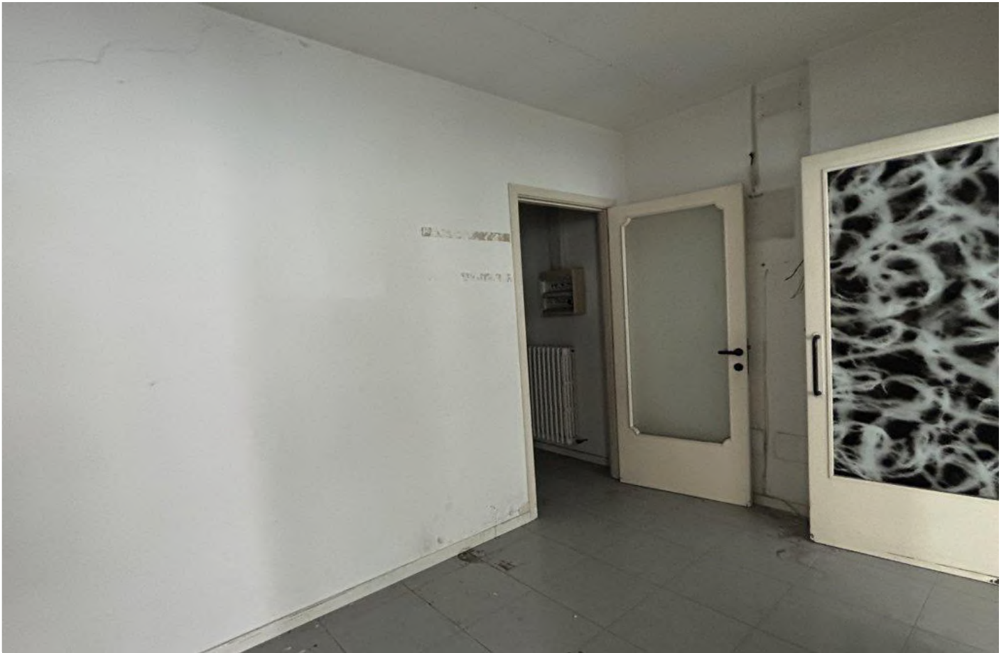
Sub. 21 - accesso disimpegno
