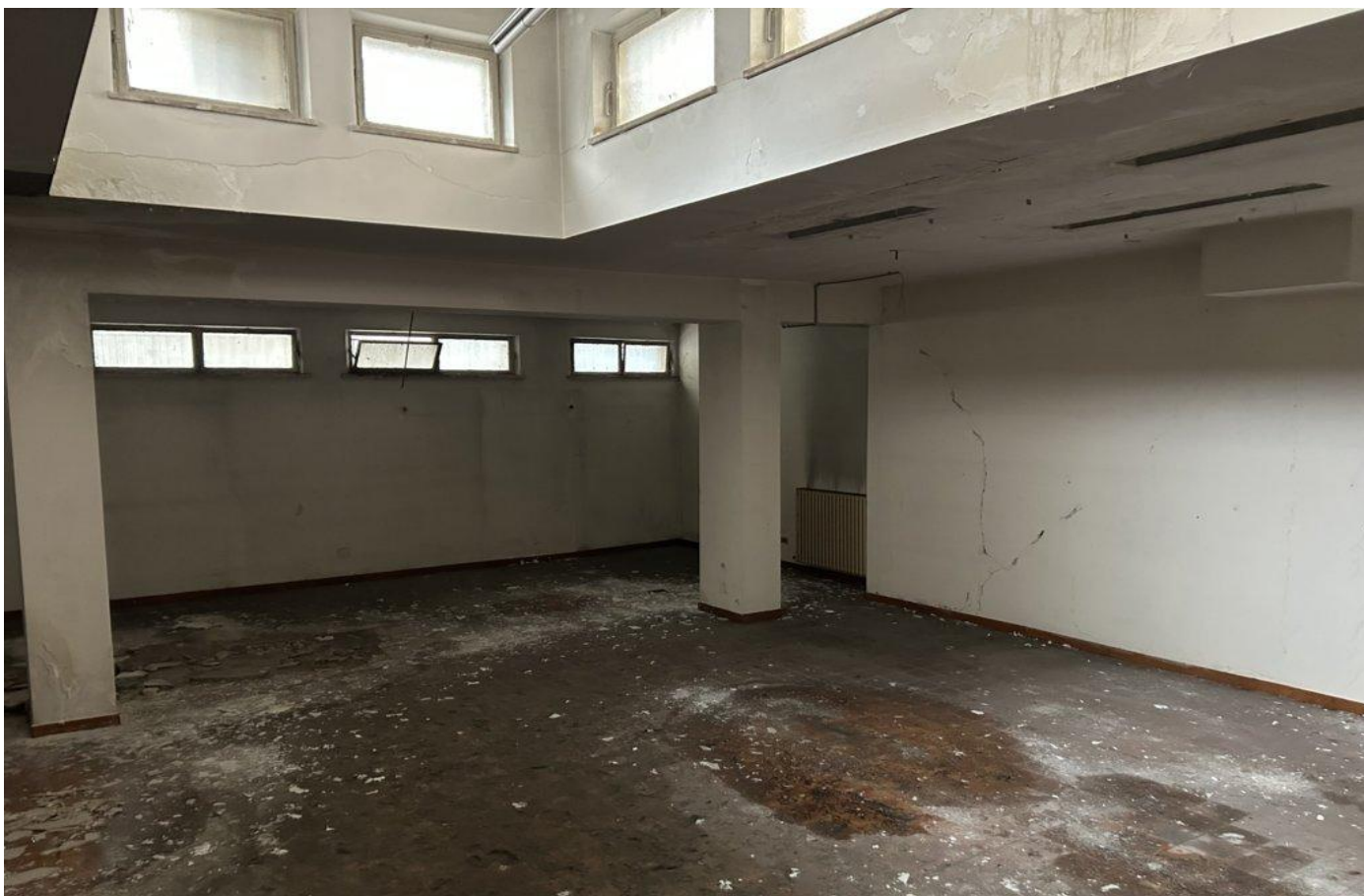
Sub. 27 -interno magazzino piano terra
