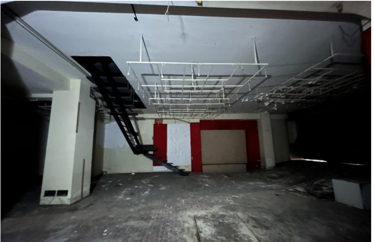
Sub. 57 - interno negozio piano seminterrato
