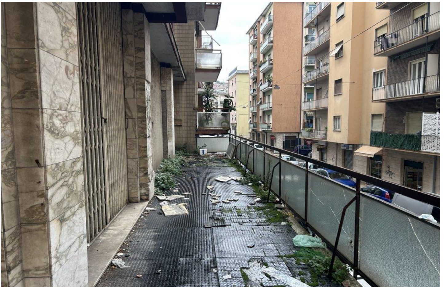
Sub. 57 - balcone a livello
