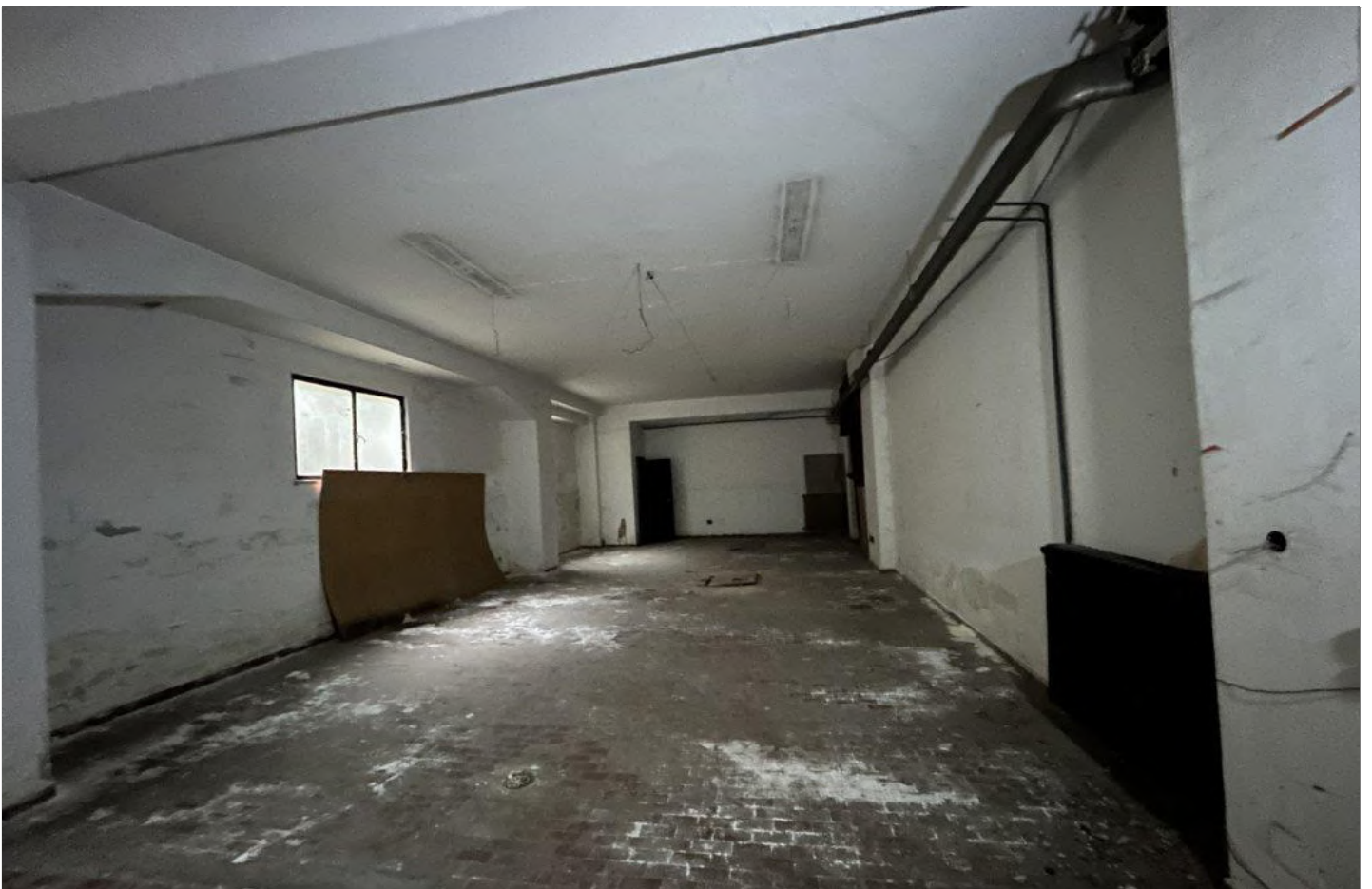
Sub. 57 - interno negozio piano seminterrato
