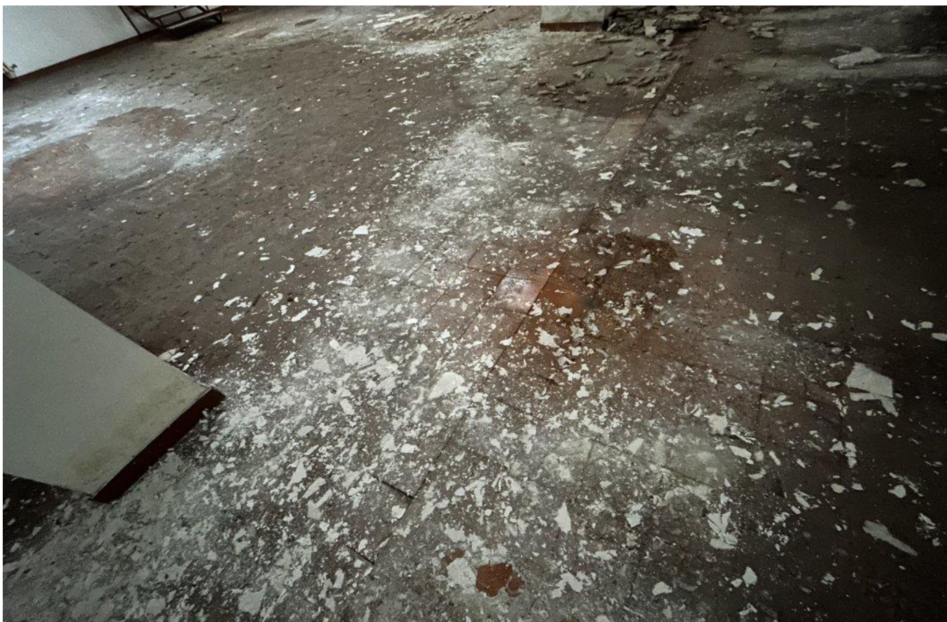
Sub. 27 -interno magazzino piano terra - particolare rialzo pavimento
