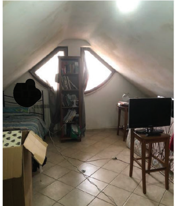
Figura 10_Vista soffitta. F.* P.lla * sub.*
