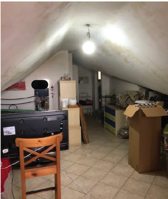
Figura 11_Vista soffitta. F.* P.lla * sub.*
