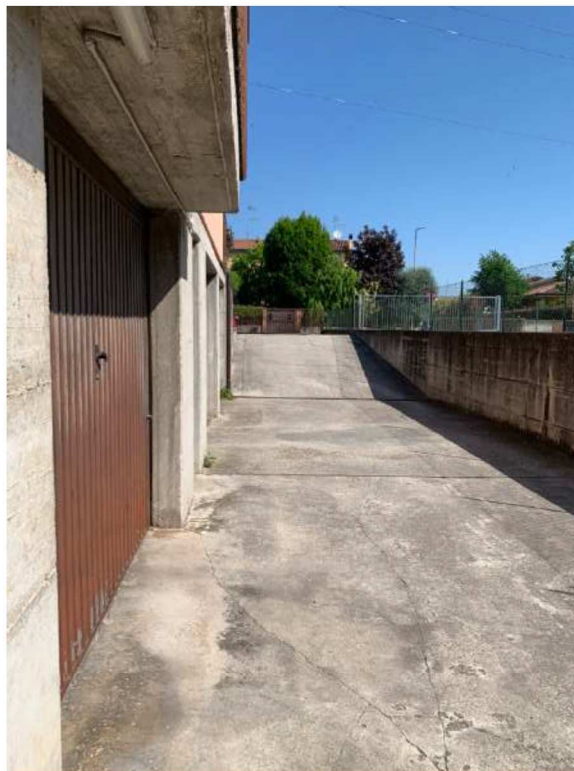
Esterno garage e rampa di accesso
