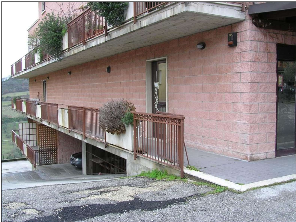
Lotto 3: bene A, ingressi dal ballatoio lato Sud
