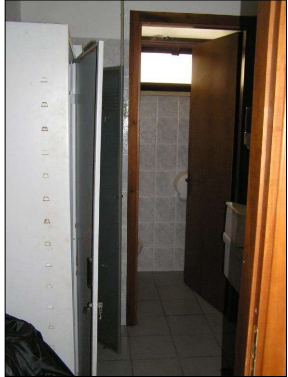
Lotto 3: bene A, antibagno 1 adibito a spogliatoio
