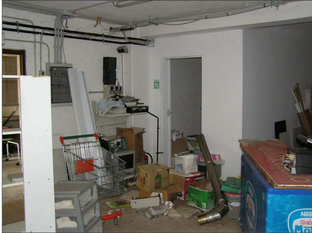
Lotto 3: bene M, interno del magazzino ubicato in S1
