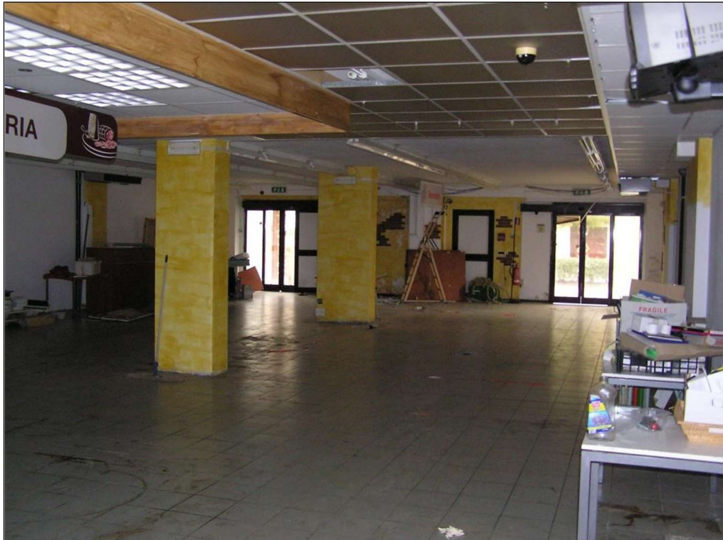
Lotto 3: bene A, locale adibito ad uso commerciale (market), verso Est, verso ingressi
