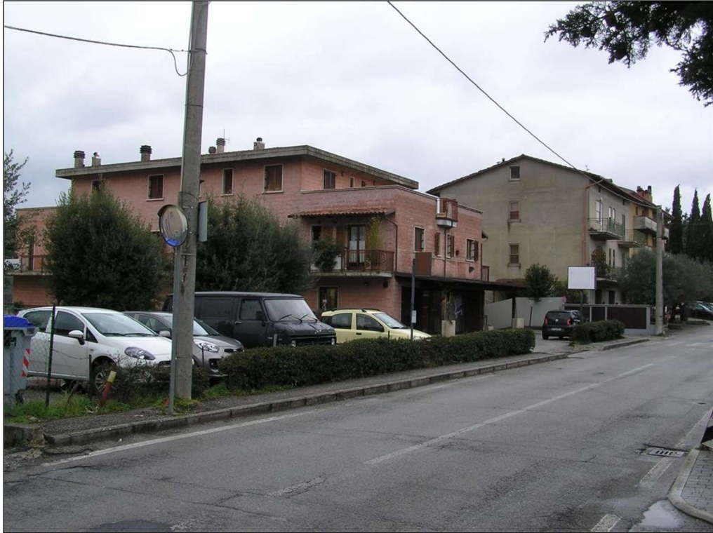
Lotto 3: fabbricato di maggiori dimensioni, da Via delle Ghiande verso Nord Ovest
