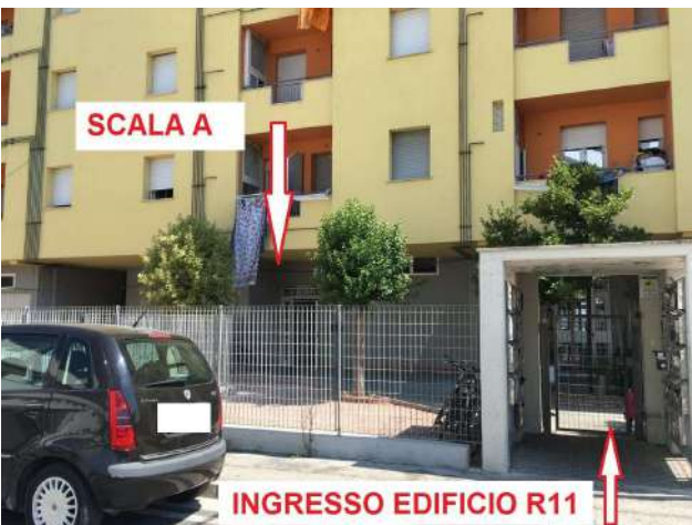
INGRESSO R11 E SCALA A, VIA SEGNI
