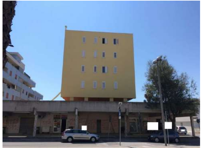
LATO NORD DELL'EDIFICIO R11
