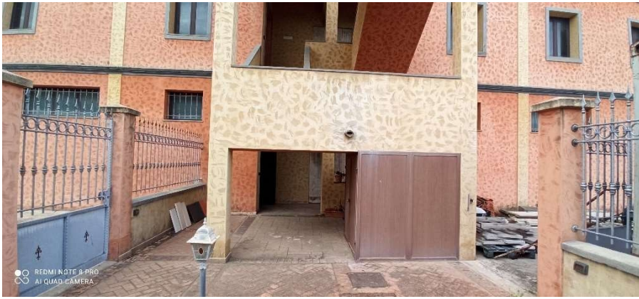
vista vano scala esterno comune
