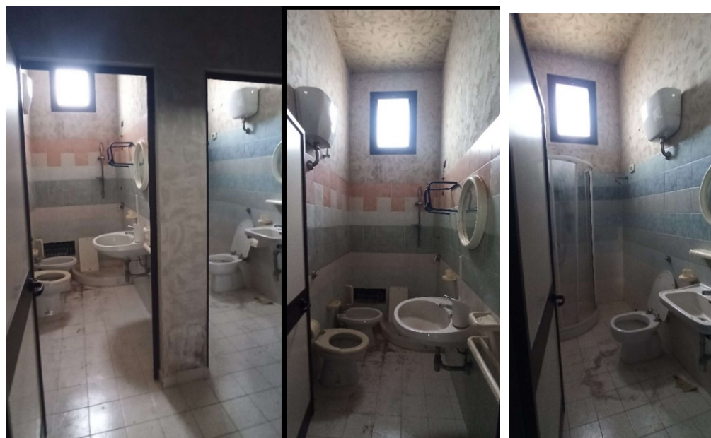
vista interna piano terra lato sx, sub.8 – servizi igienici
