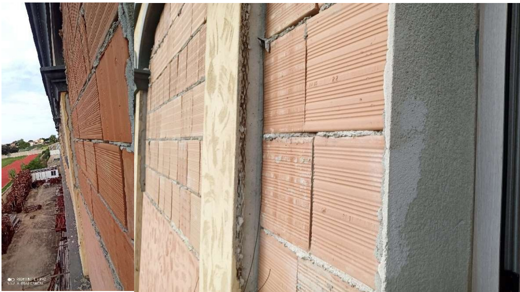
Vista scorciatoia tamponatura esterna ufficio 1 e 2 sub 12 - 13 - non finito
