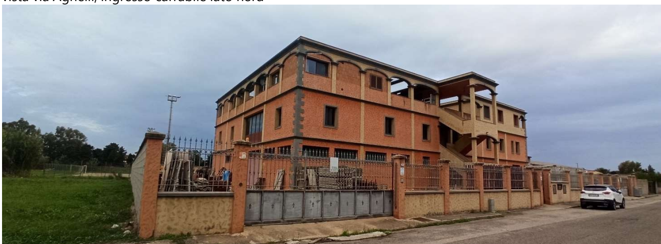
vista via Agnelli, ingresso carrabile lato sud
