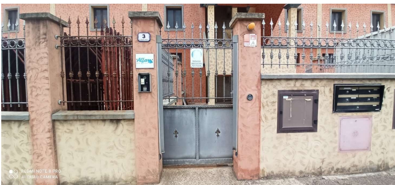
vista via Agnelli, ingresso pedonale
