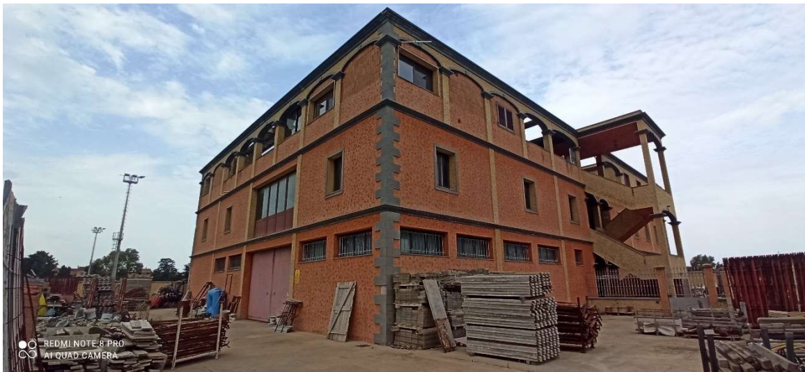
Vista cortile esterno lato sinistro
