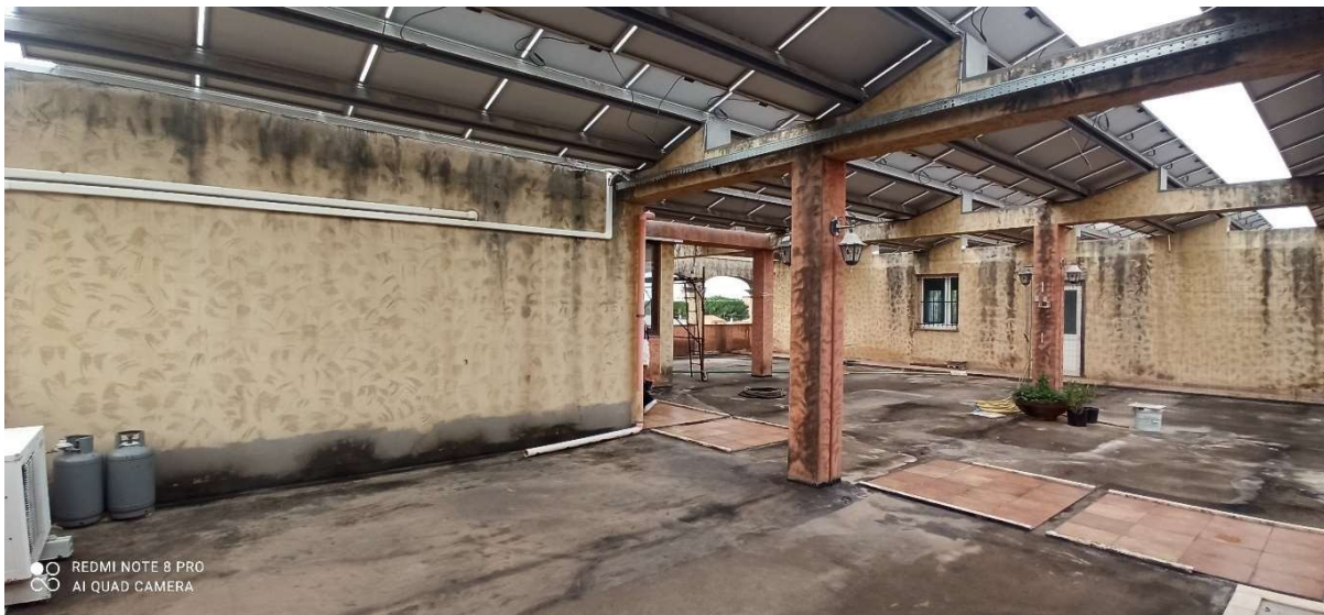
vista esterna piano secondo – terrazzo (sub.18 e 19)
