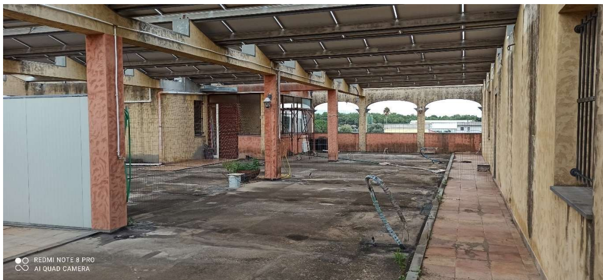
Vista esterna piano secondo – terrazzo (sub. 18 e 19)
