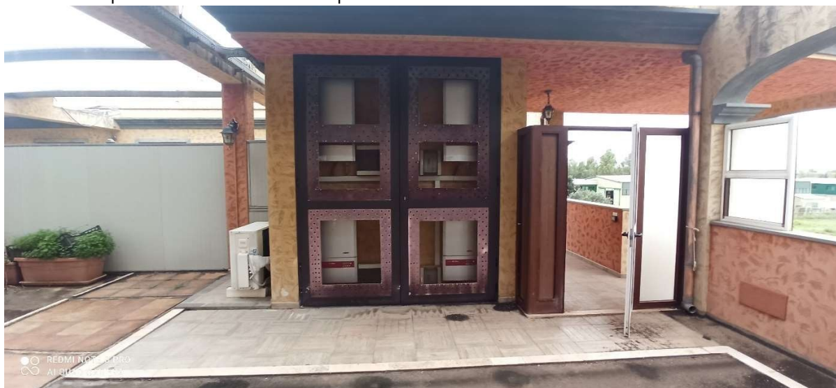
vista esterna piano secondo – accesso al piano lato sx e locale tecnico ascensore
