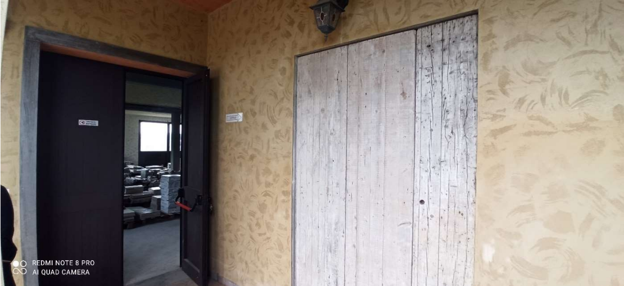
vista interna piano primo lato sx, sub.10 – ingresso e vano ascensore chiuso
