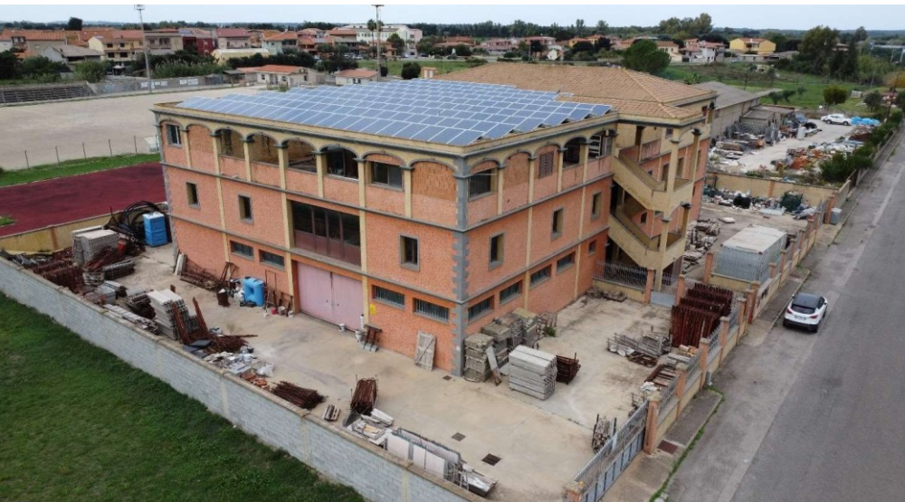
vista aerea dell'immobile, angolo sud
