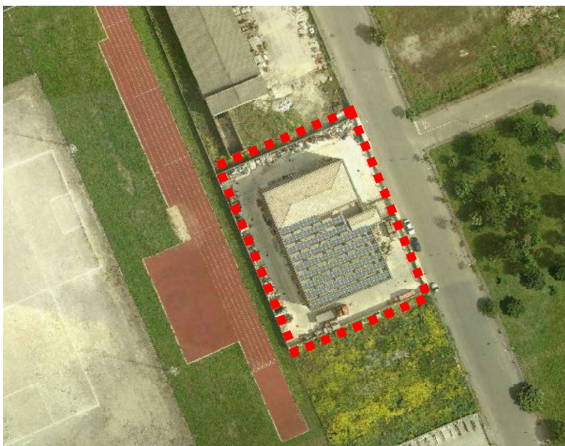
ortofoto satellitare 2010 presenza del fabbricato
