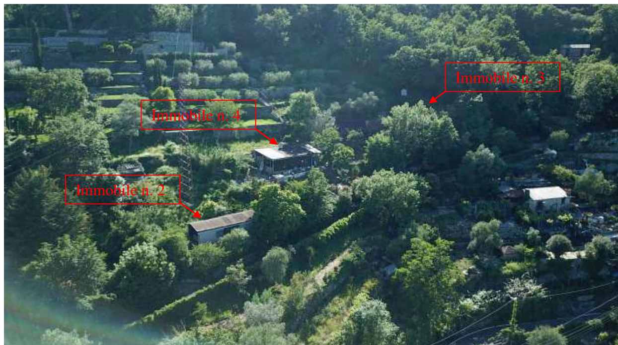
Immobili n.ro 2, 3, 4, interessati dall'accorpamento. Vista panoramica dell'area (da pratica di progetto Geom.Lunghi)
