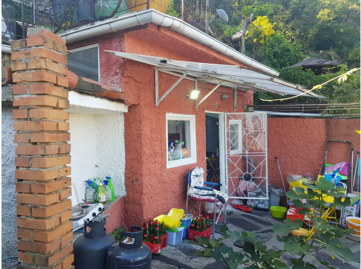
Immobile n.ro 6 – mappale 1380 sub 1 Vista esterna dell'ingresso (da pratica edilizia Geom.Lunghi); si evidenzia che lo spazio esterno non rientra nel pignoramento.
