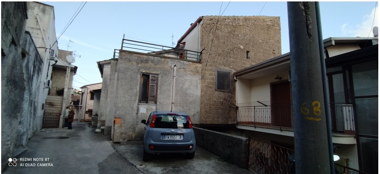
Foto 1 – vista fabbricato da via Monticello III, parte alta.
