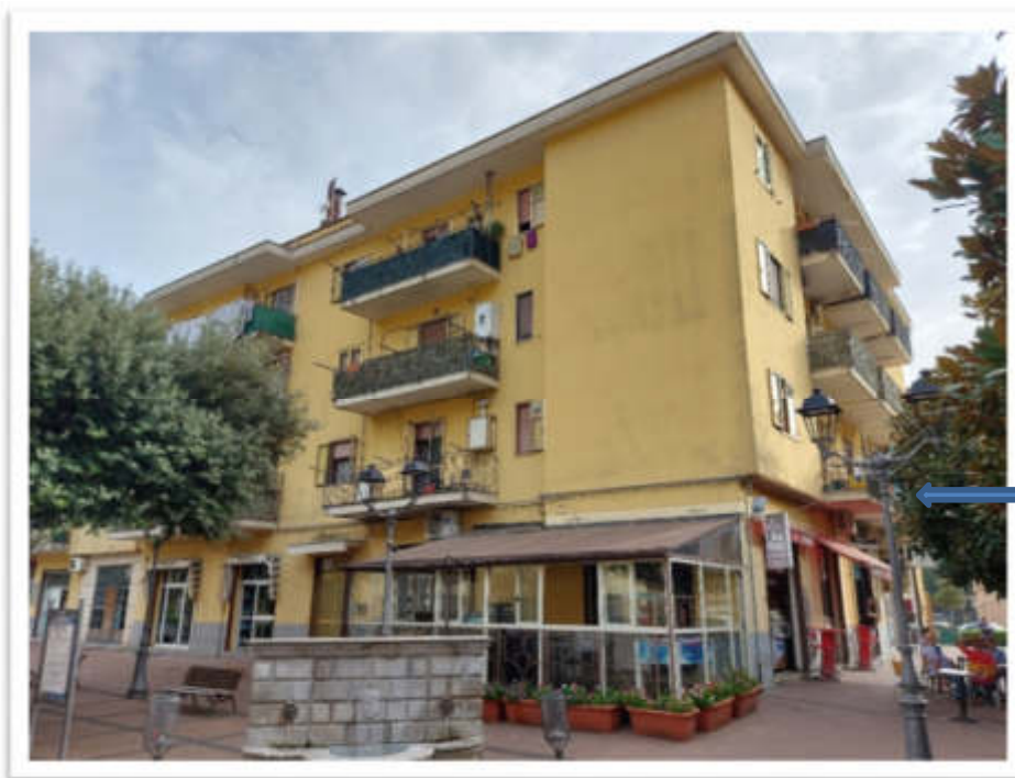
Foto n. 3 – Appartamento sito al piano 1° - Giffoni Valle Piana (SA)
