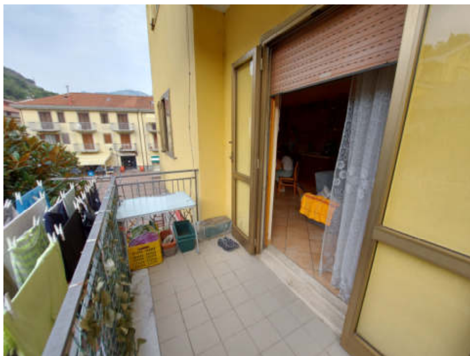
Foto n. 29 - Appartamento – Balconi/particolari infissi in legno ed alluminio
