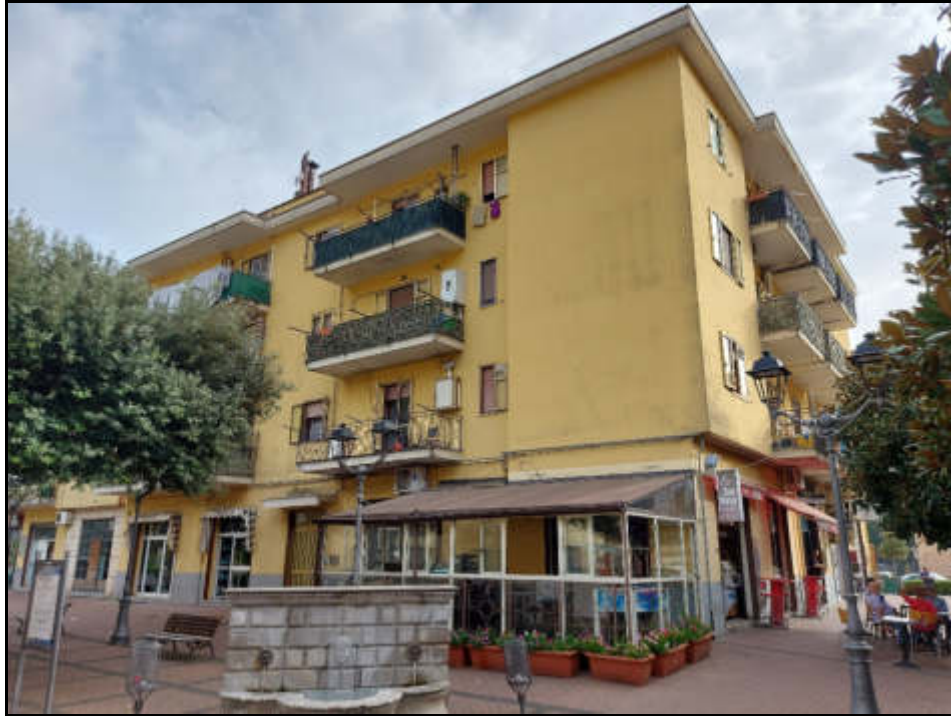
Foto n. 1 - Edificio in Piazza del Popolo n. 26 in Giffoni Valle Piana (SA) Appartamento oggetto di pignoramento al Piano 1°, int. 2
