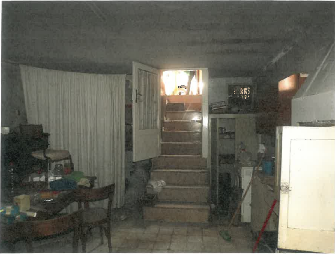
Foto 14. Piano interrato. Vano 1.
