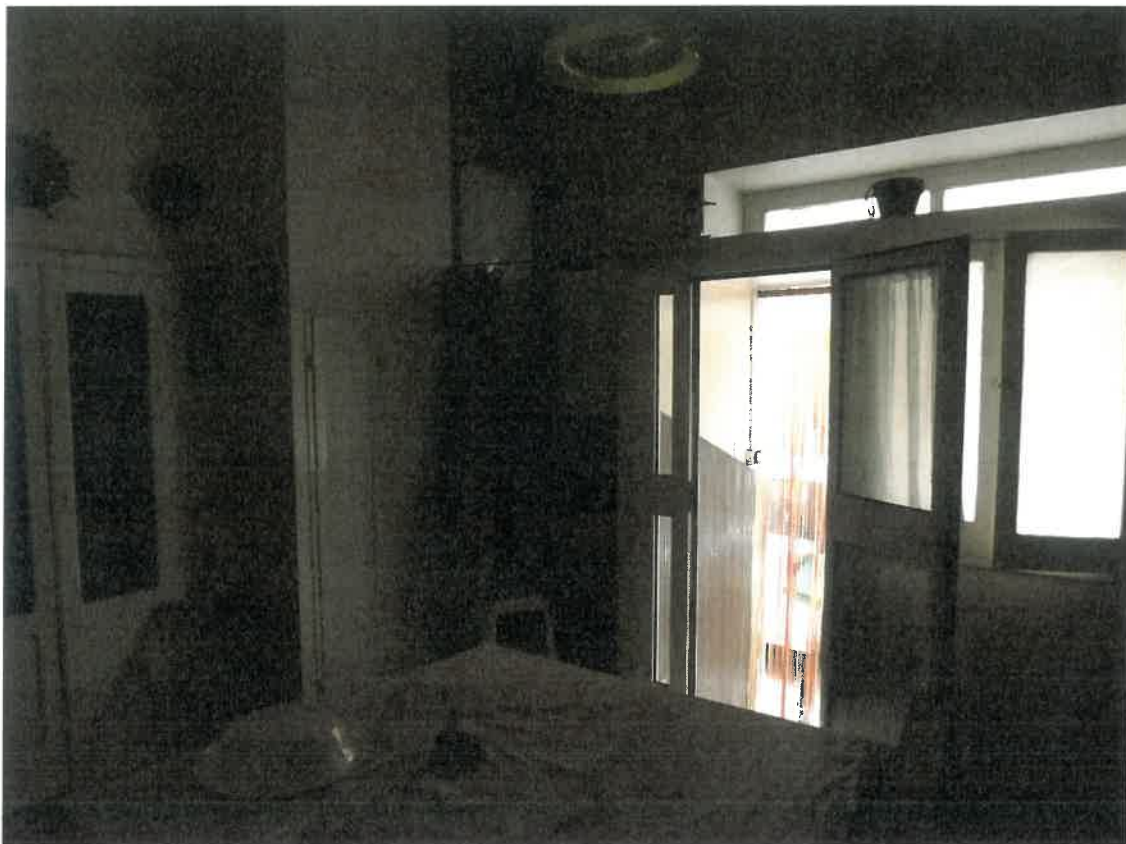
Foto 5. Piano rialzato. Vano cucina-pranzo.
