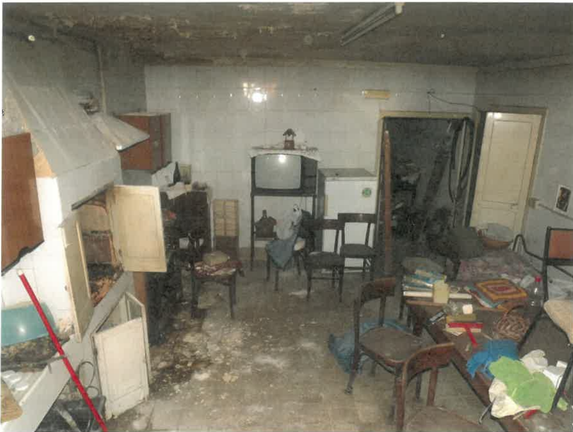
Foto 15. Piano interrato. Vano 1.
