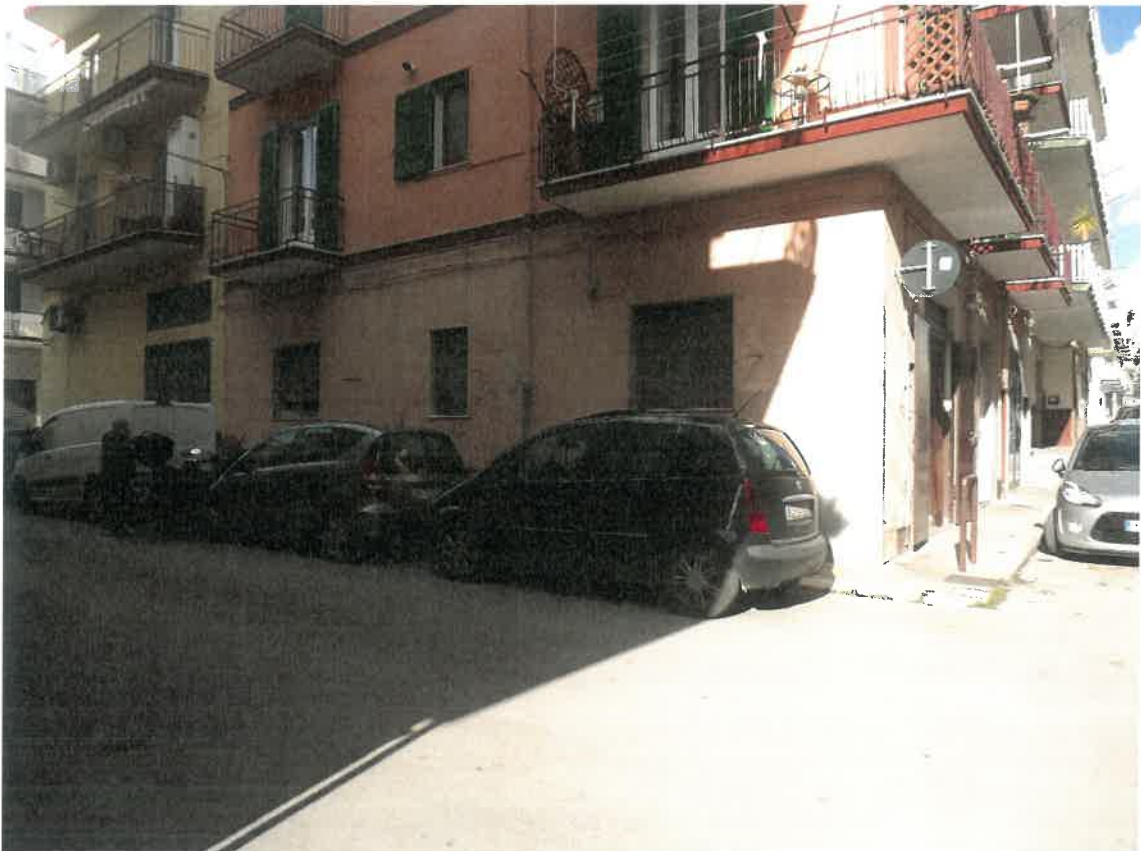
Foto 3. L'immobile. Via Nello Rosselli. Piani rialzato e interrato.
