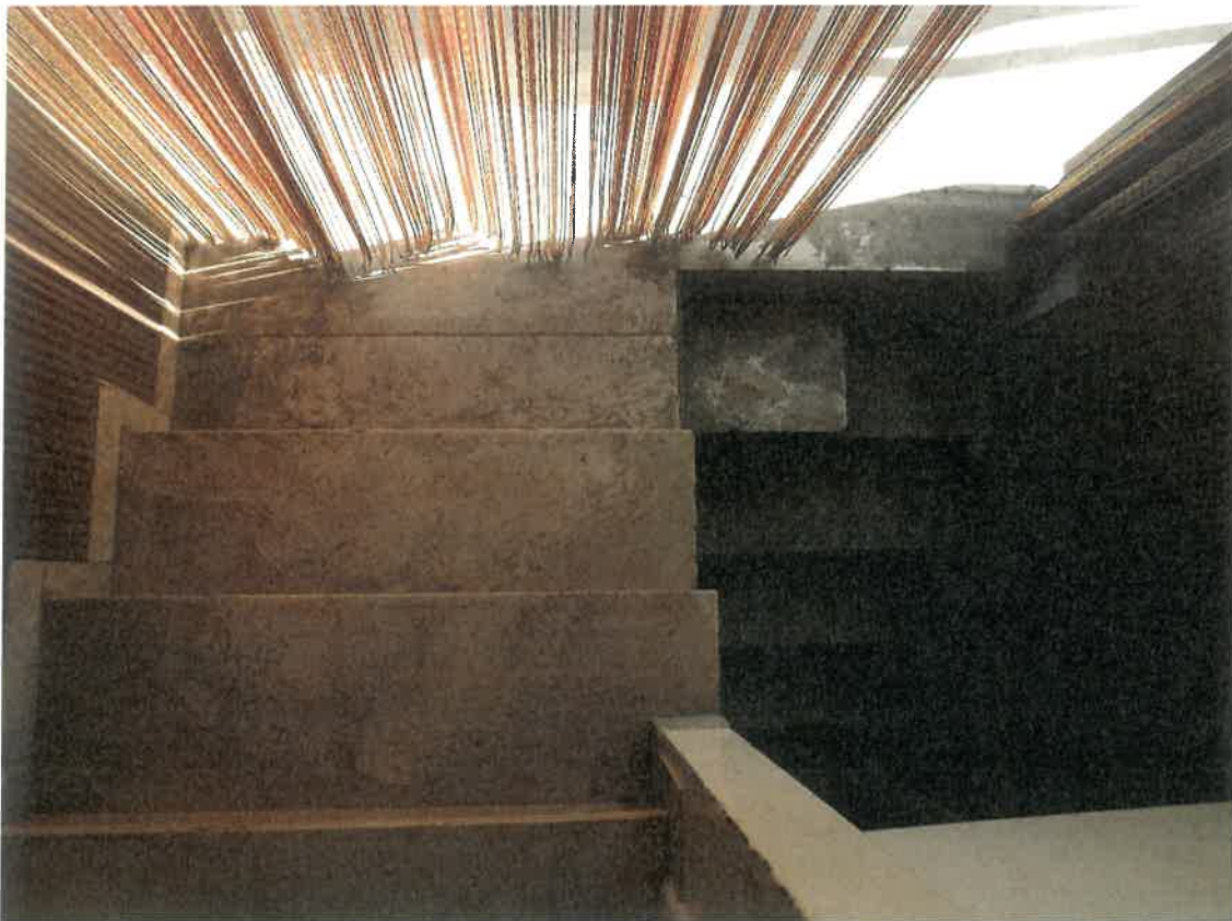
Foto 4. Scala di accesso ai piani rialzato e interrato.
