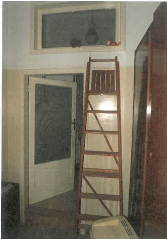
Foto 9. Piano rialzato. Disimpegno. Ingresso al bagno.
