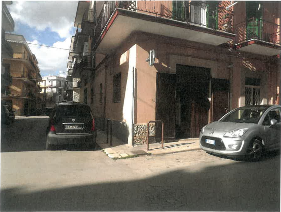
Foto 2. L'immobile. Via Tenente Colonnello Fiore n. 42. Piani rialzato e interrato.
