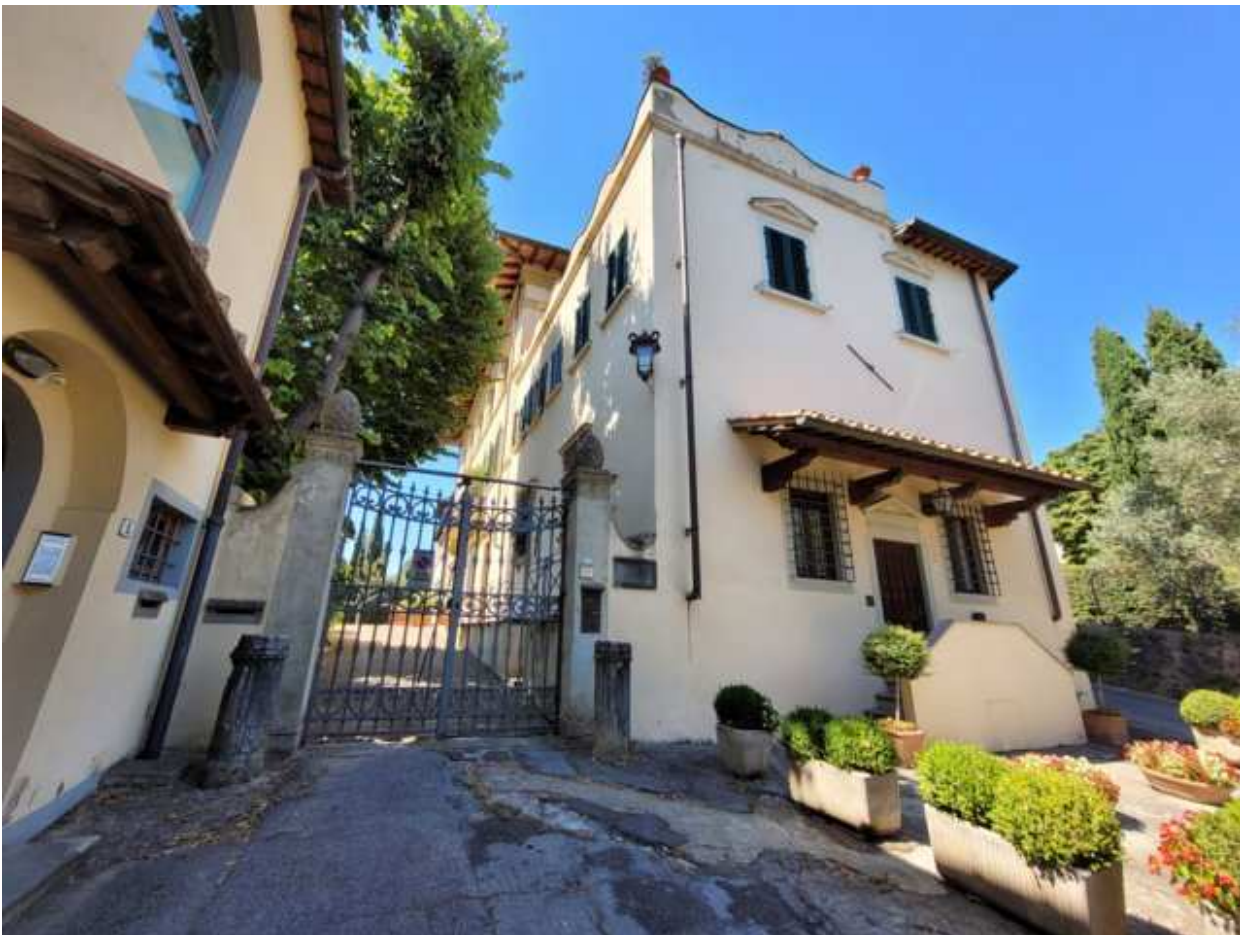
Foto n. 1 – Cannello di accesso da Via Montalbano n. 3
