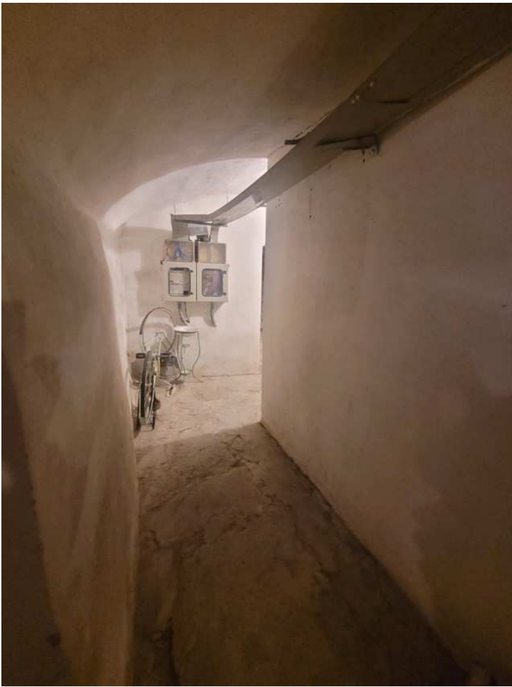
Foto n. 30 – Corridoio per le cantine
