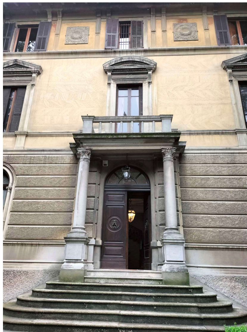
INGRESSO PRINCIPALE LOTTO 1 NOVI
