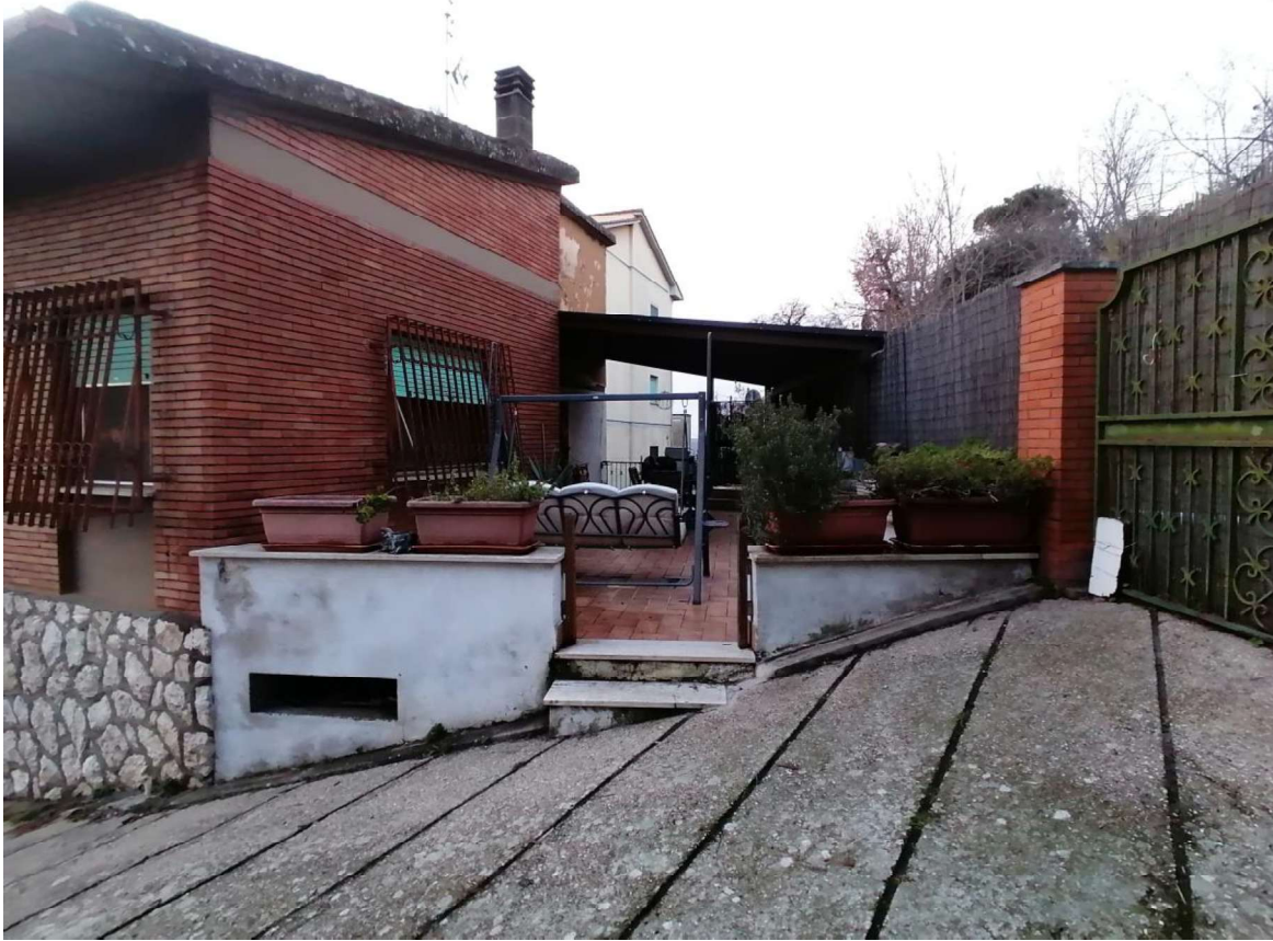
FOTO N°05: Particolare della rampa e della corte di ingresso.
