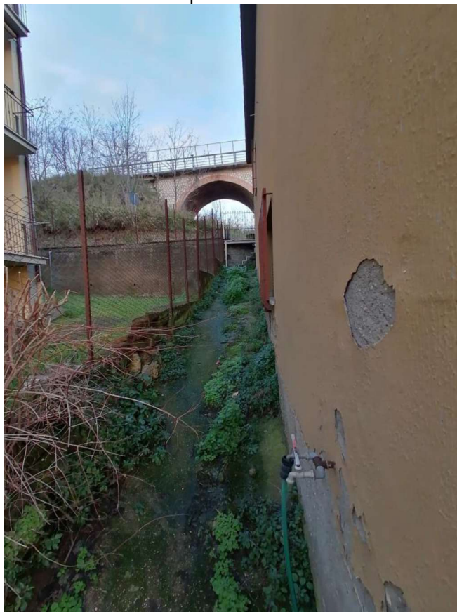
FOTO N°03: Prospetto Nord – vista dal basso.
