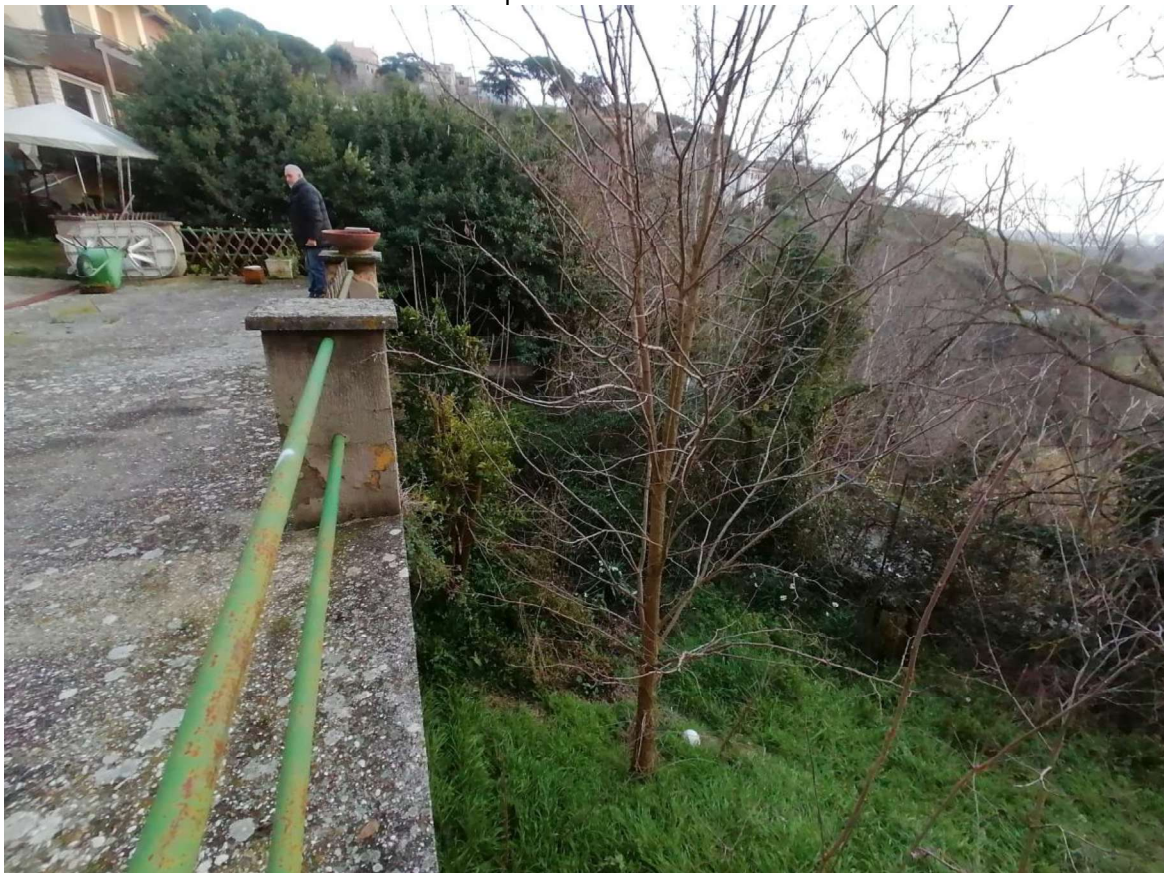
FOTO N°36: corte al piano sottostrada – zona scoscesa.
