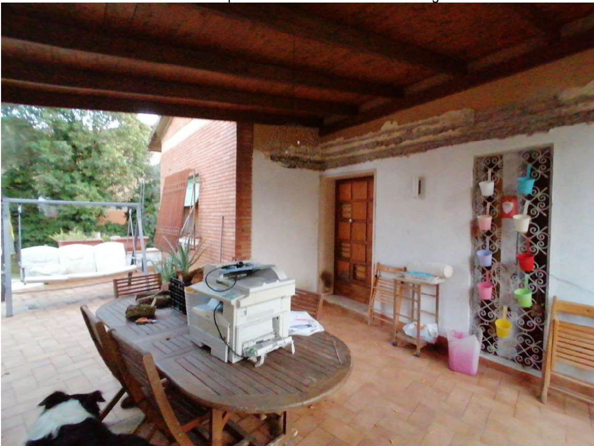
FOTO N°06: Prospetto Ovest – Portico su zona di ingresso.
