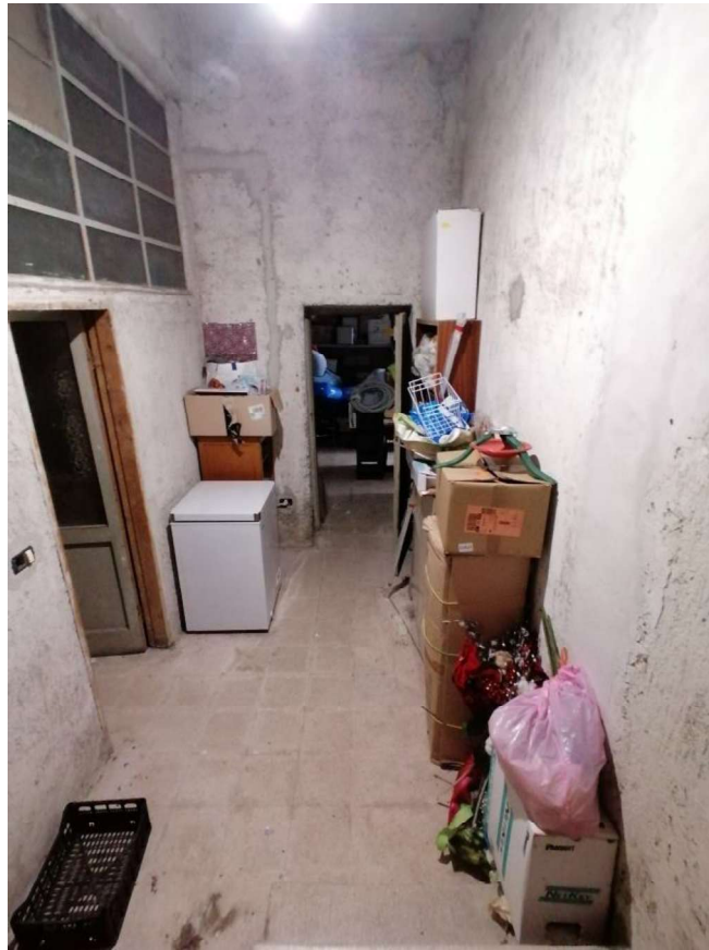
FOTO N°29: Connettivo al Piano Sottostrada.
