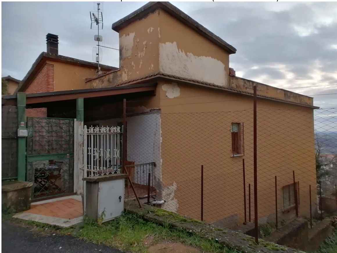
FOTO N°07: Prospetto Nord – Vista dall'alto (Via di Santa Maria).
