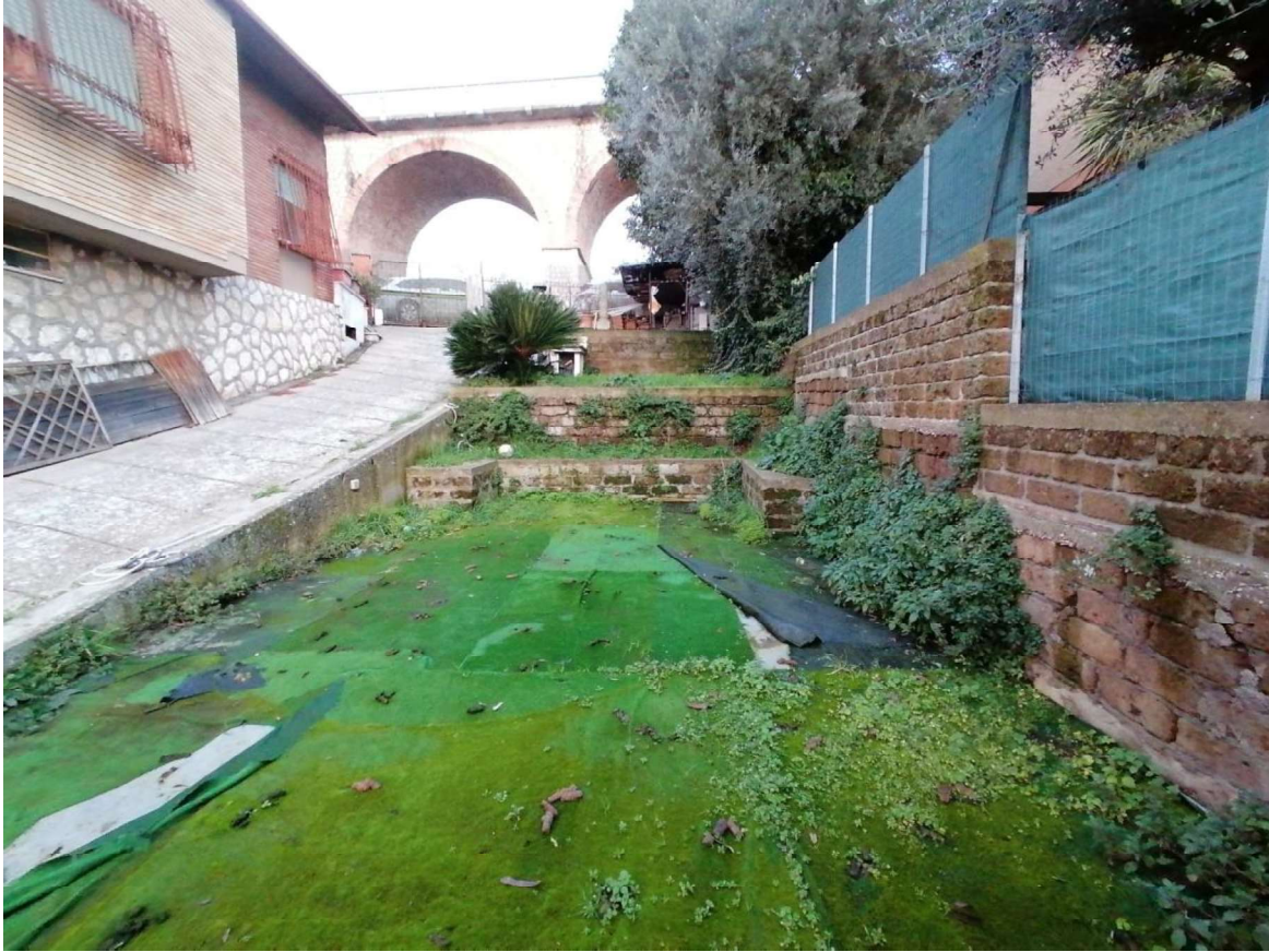
FOTO N°39 Corte esterna – particolare relativo alla parte terrazzata.
