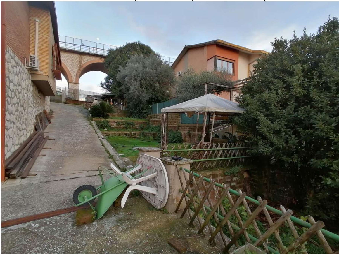
FOTO N°37 Corte esterna – rampa di accesso al piano seminterrato e parte terrazzata.
