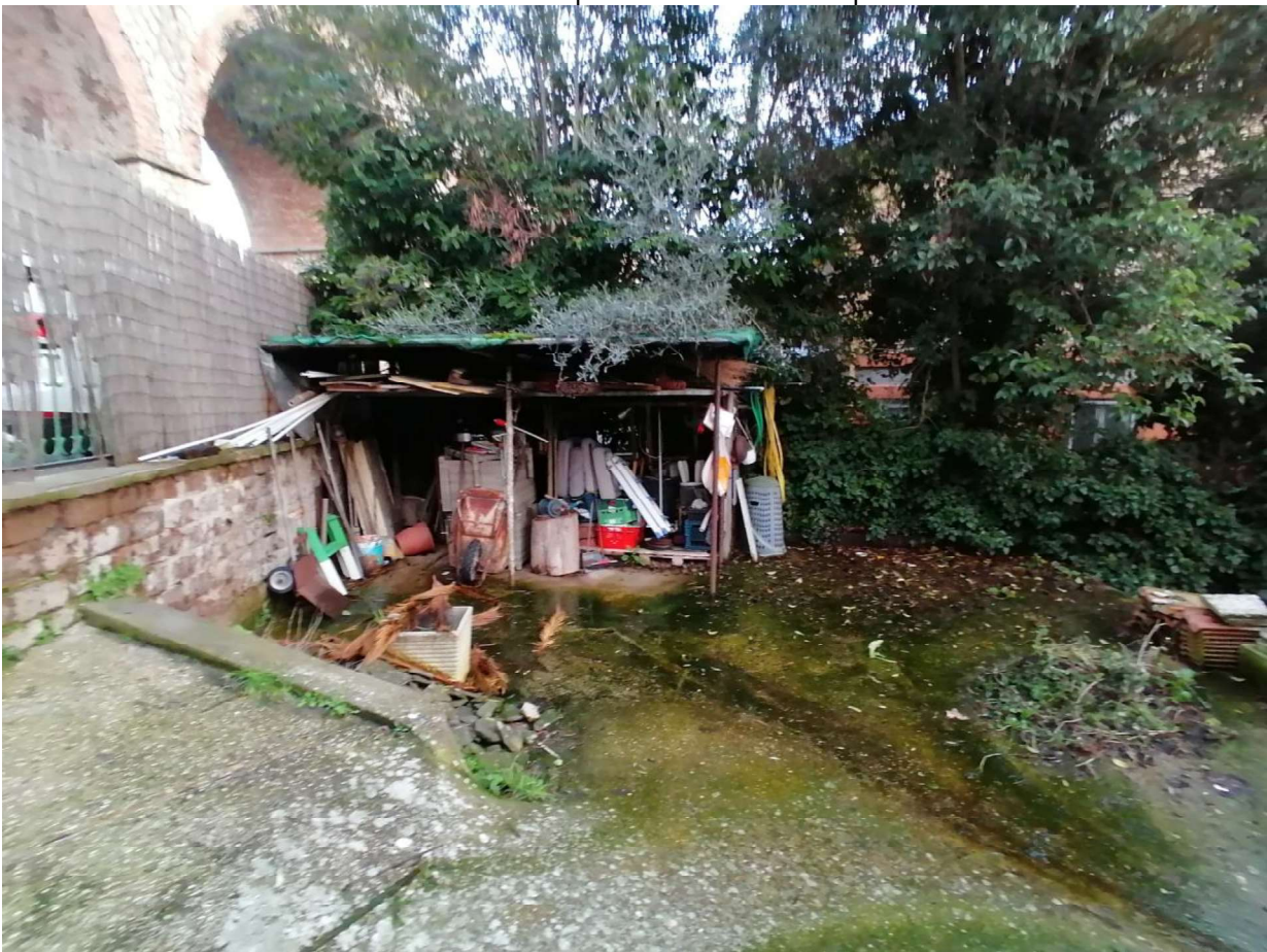
FOTO N°40: Corte esterna – particolare relativo alla parte terrazzata.
