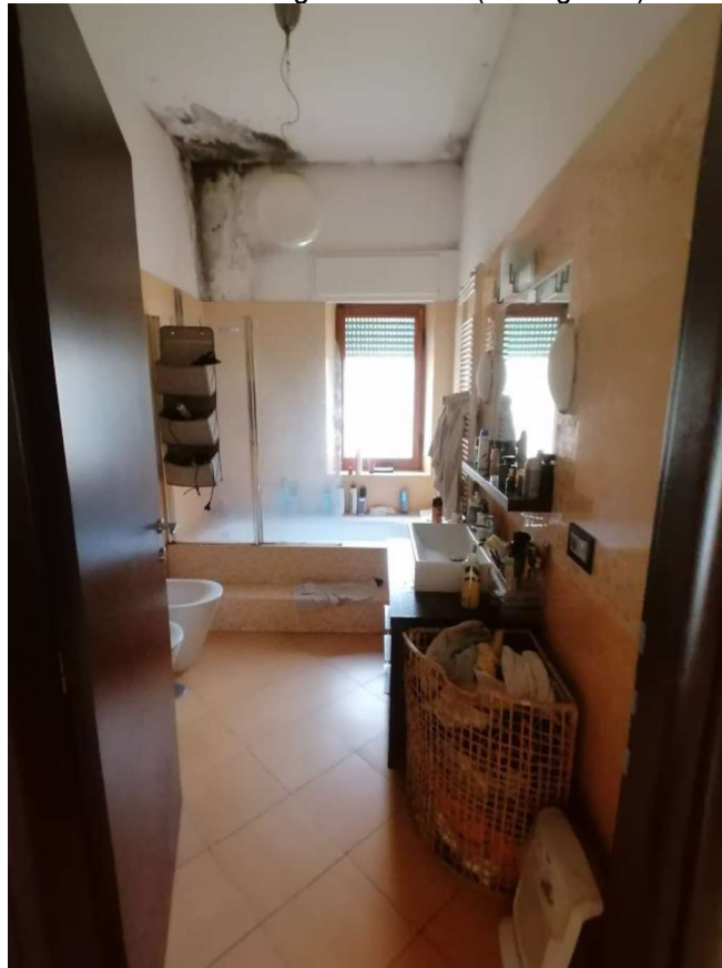
FOTO N°17: Bagno n.1 al PT (zona giorno).
