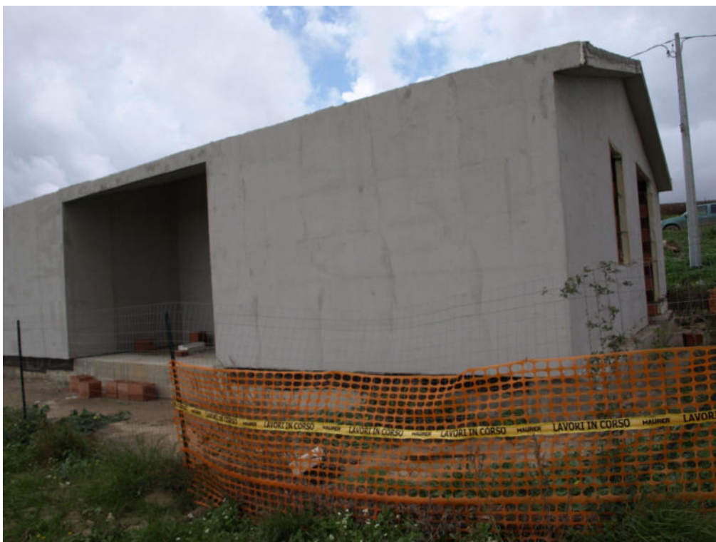
Foto n° 3 – Fabbricato rurale sito in Butera c.da Gurgazzi – Foglio 77, part. 84 – Panoramica degli esterni del fabbricato rurale oggetto di lavori di demolizione e ricostruzione con miglioramento sismico ed energetico.
