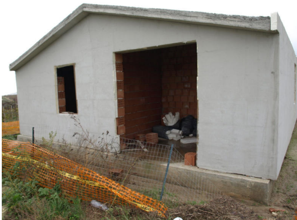
Foto n° 2 – Fabbricato rurale sito in Butera c.da Gurgazzi – Foglio 77, part. 84 – Panoramica degli esterni del fabbricato rurale oggetto di lavori di demolizione e ricostruzione con miglioramento sismico ed energetico.
