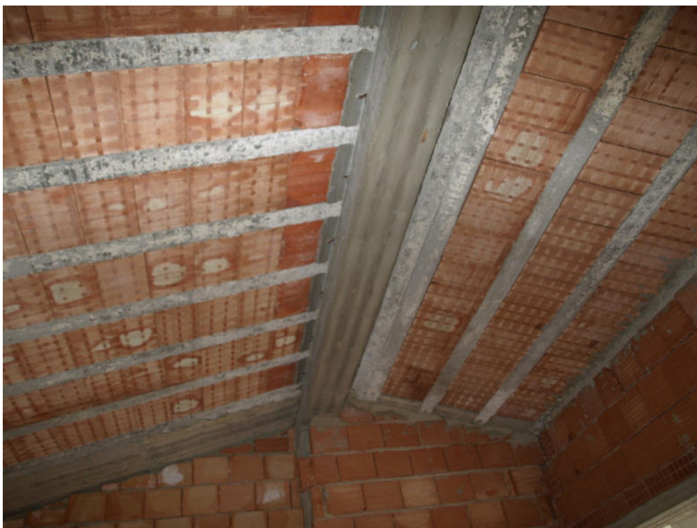
Foto n° 9 – Fabbricato rurale sito in Butera c.da Gurgazzi – Foglio 77, part. 84 – Panoramica degli interni del fabbricato rurale oggetto di lavori di demolizione e ricostruzione con miglioramento sismico ed energetico.
