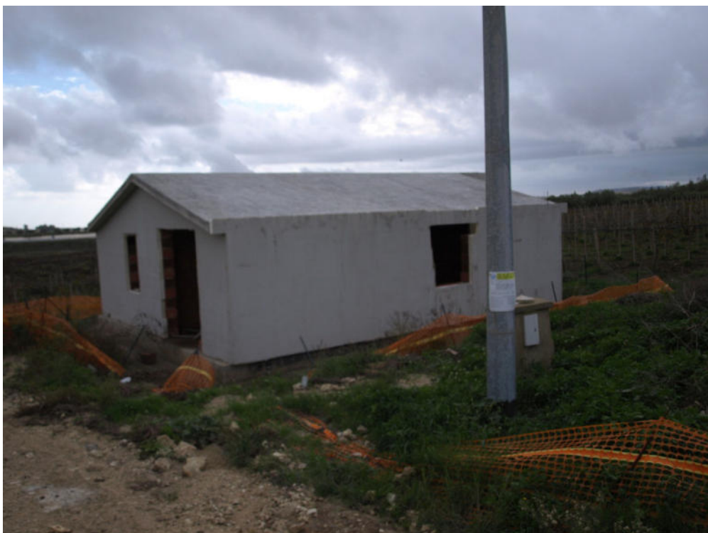
Foto n° 1 – Fabbricato rurale sito in Butera c.da Gurgazzi – Foglio 77, part. 84 – Panoramica degli esterni del fabbricato rurale oggetto di lavori di demolizione e ricostruzione con miglioramento sismico ed energetico.
