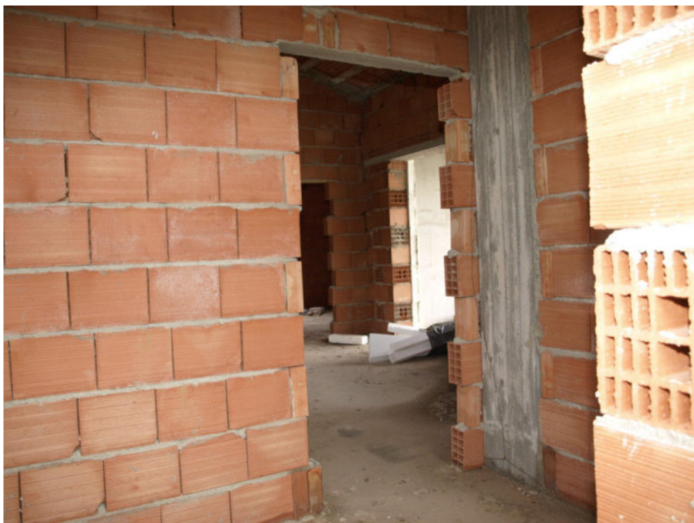
Foto n° 7 – Fabbricato rurale sito in Butera c.da Gurgazzi – Foglio 77, part. 84 – Panoramica degli interni del fabbricato rurale oggetto di lavori di demolizione e ricostruzione con miglioramento sismico ed energetico.
