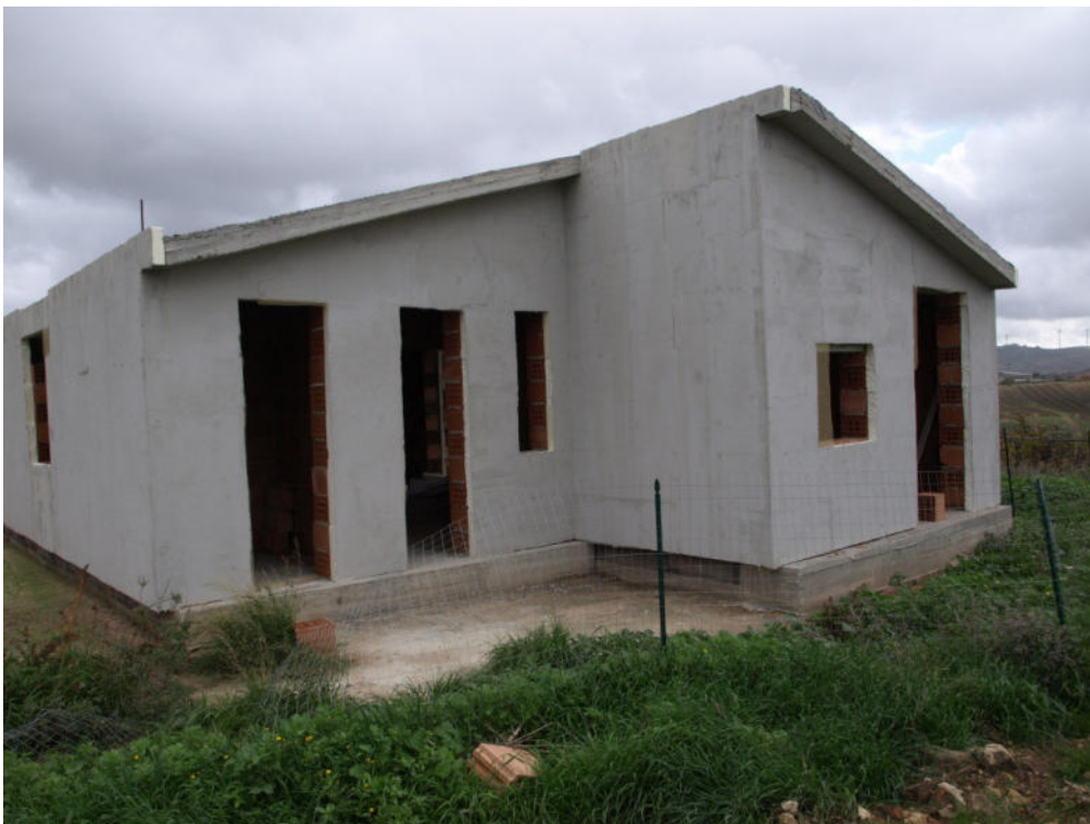
Foto n° 6 – Fabbricato rurale sito in Butera c.da Gurgazzi – Foglio 77, part. 84 – Panoramica degli esterni del fabbricato rurale oggetto di lavori di demolizione e ricostruzione con miglioramento sismico ed energetico.
