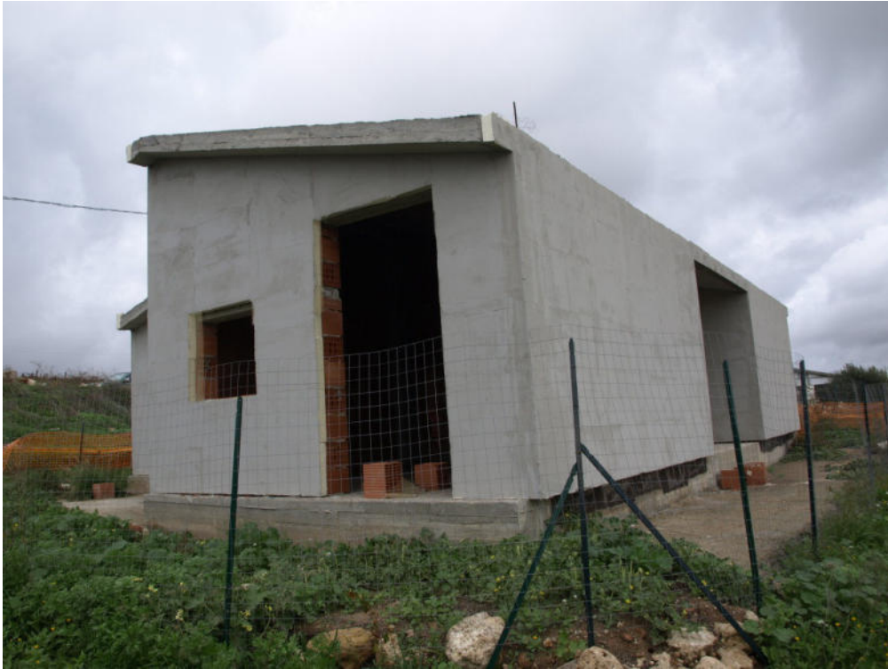
Foto n° 5 – Fabbricato rurale sito in Butera c.da Gurgazzi – Foglio 77, part. 84 – Panoramica degli esterni del fabbricato rurale oggetto di lavori di demolizione e ricostruzione con miglioramento sismico ed energetico.
