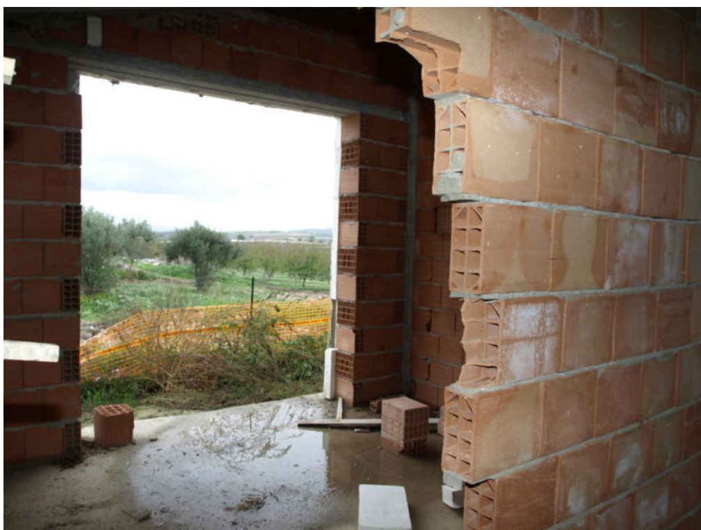
Foto n° 10 – Fabbricato rurale sito in Butera c.da Gurgazzi – Foglio 77, part. 84 – Panoramica degli interni del fabbricato rurale oggetto di lavori di demolizione e ricostruzione con miglioramento sismico ed energetico.
