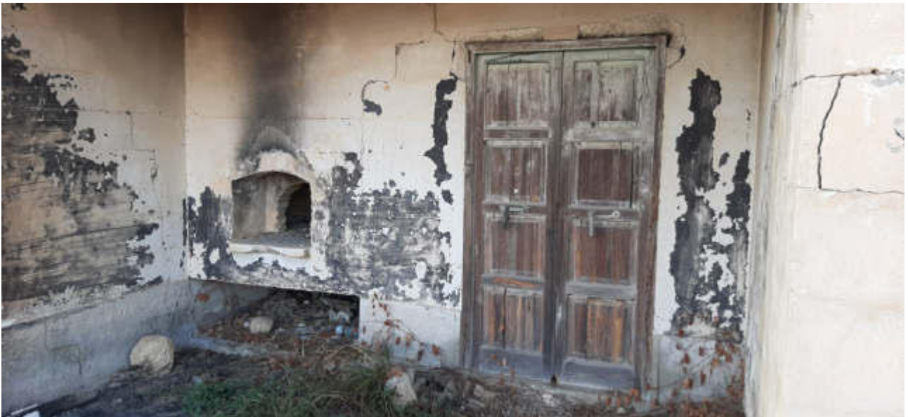
Foto n° 4 – Immobili siti in Butera c.da Gurgazzi – Foglio 77, part. 84 – Particolare dell'ingresso del fabbricato rurale.
