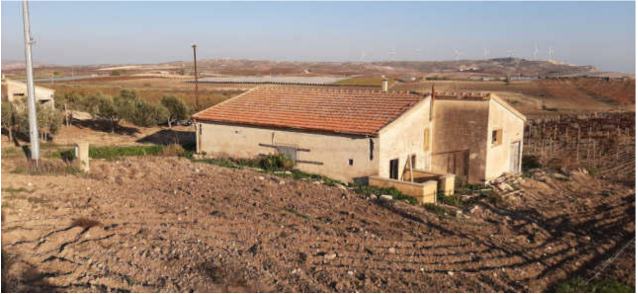
Foto n° 3 – Immobili siti in Butera c.da Gurgazzi – Foglio 77, part. 84 – Panoramica del fabbricato rurale e del terreno retrostante distinto in catasto alla particella 153.
