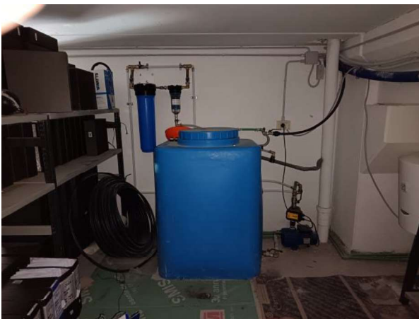
Soppalco locale tecnico
