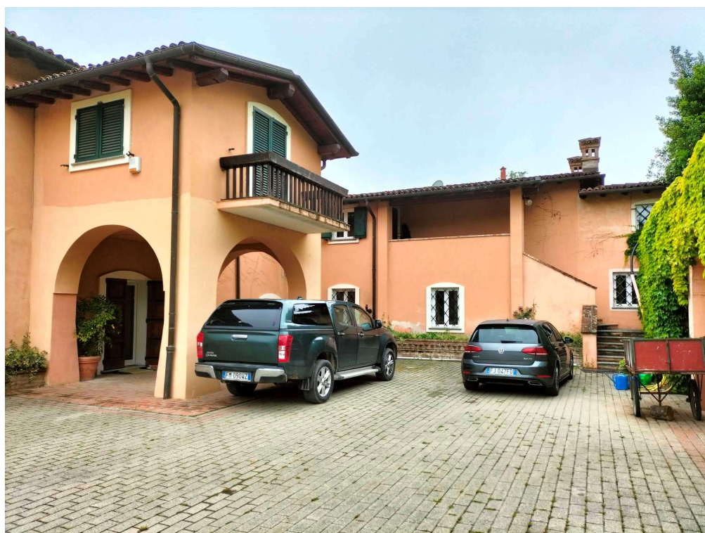
Vista arrivando da accesso principale
