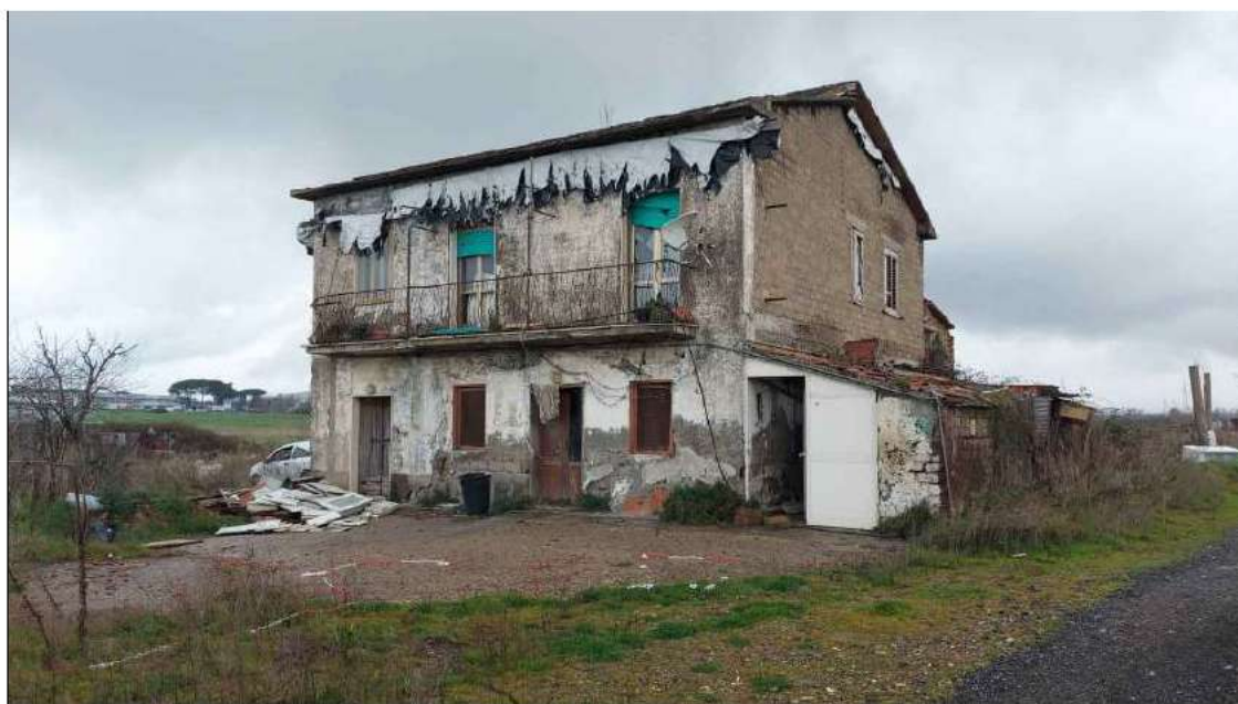
foto 13 - vista esterna d'insieme da sud-est del fabbricato sul quale è posta al p.1° l'abitazione - Lotto n. 3.
