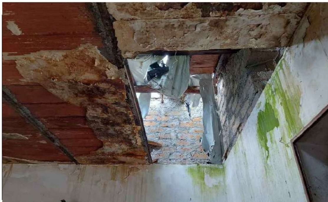
foto 18 - dettaglio della bucatura del solaio di plafonatura - Lotto n. 3.
