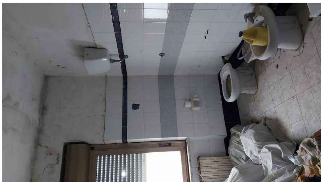
foto 27 - vista del bagno - Lotto n. 3.
