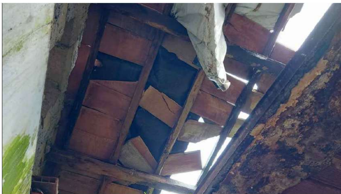
foto 19 - dettaglio delle bucatore del solaio di plafonatura e di quello soprastante già di copertura - Lotto n. 3.
