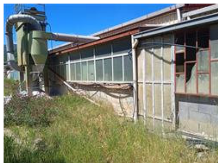
Foto n. 53 particolare esterno del capannone
