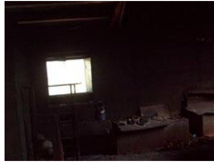
Foto n. 85 capannone incendiato sub 4
