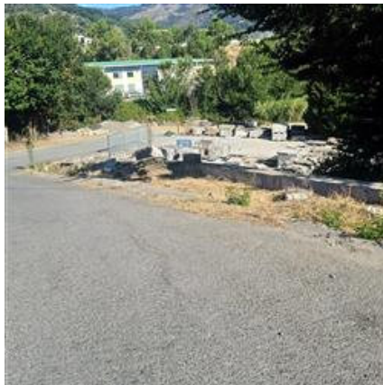
Foto n. 61 strada di accesso che si innesta con la strada provinciale 122 già inserita nel corpo A
