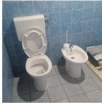
Foto n. 66 bagno di servizio per il personale
