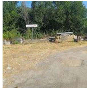
Foto n. 76 strada comunale di accesso area industriale lotto n. 8 autocarrozzeria
