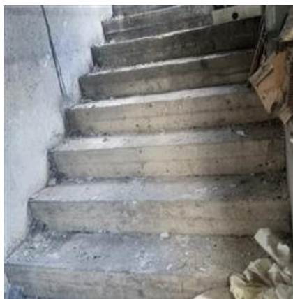
Foto n. 83 scala di accesso al primo piano dall'immobile sub 2 al sub 4
