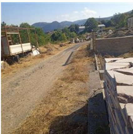
Foto n. 82 strada comunale di accesso al lotto n. 9
