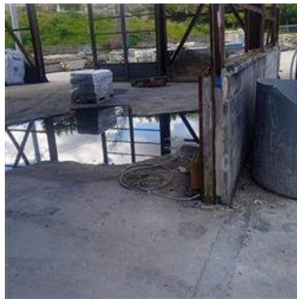
Foto n. 68 interno capannone ripulito dai rifiuti
