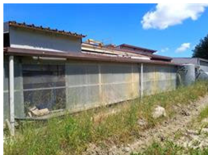
Foto n. 54 particolare esterno del capannone
