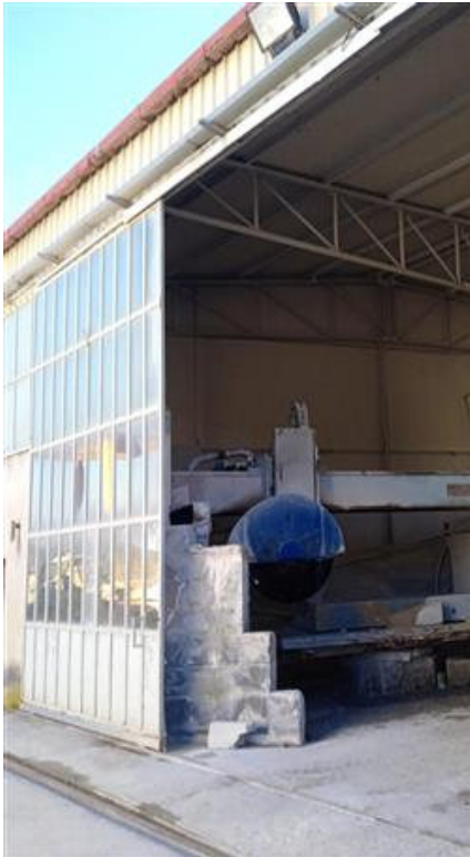
Foto n. 39 parete esterna capannone
