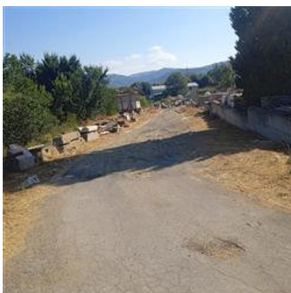
Foto n. 77 strada comunale di accesso area industriale lotto 8
