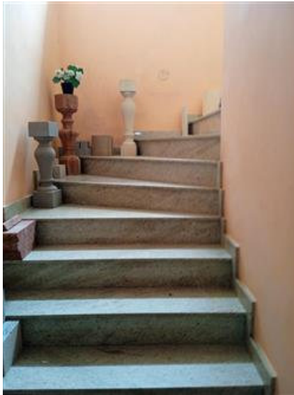
foto n. 43 scala di accesso uffici al primo piano
