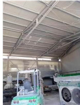
Foto n. 56 interno capannone part.481
