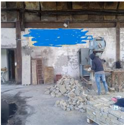
Foto n. 67 interno capannone sistemato per lavorazione pietre
