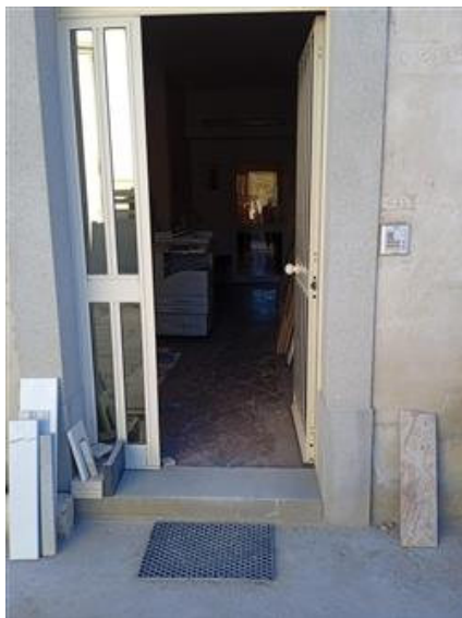
foto n. 41 Ingresso ufficio fabbricato foglio 10 part.391 sub 1 piano terra
