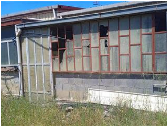
Foto n. 55 particolare esterno del capannone
