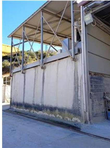
foto n. 50 terreno part. 481 con tettoia
