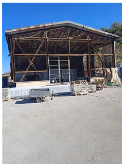
Foto n. 71 capannone lato est con terreno particella 589
