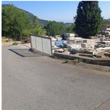
Foto n. 62 Cancello ingresso lotto n. 7
