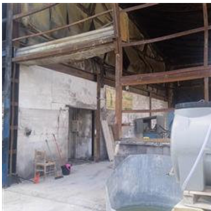
Foto n. 63 interno magazzino in parte ripulito
