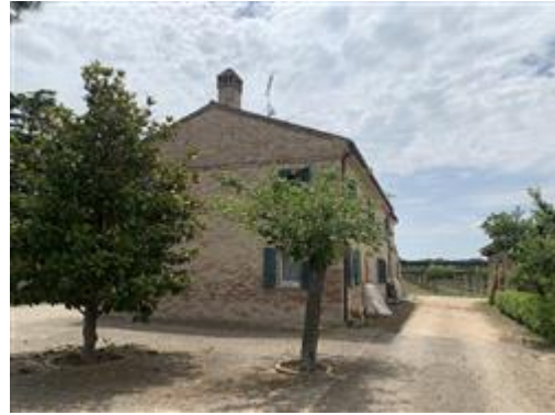
Esterno lato Est
