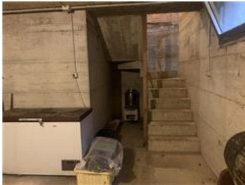
Scala interna di accesso al locale interrato
