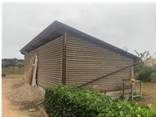
Rimessa attrezzi realizzata senza autorizzazione
