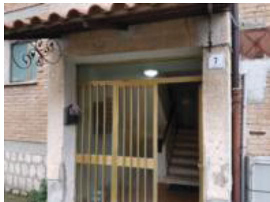
Figura 4 – Vista Portone Ingresso condominio –
