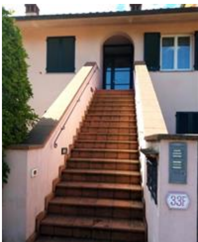
scala esterna condominiale
