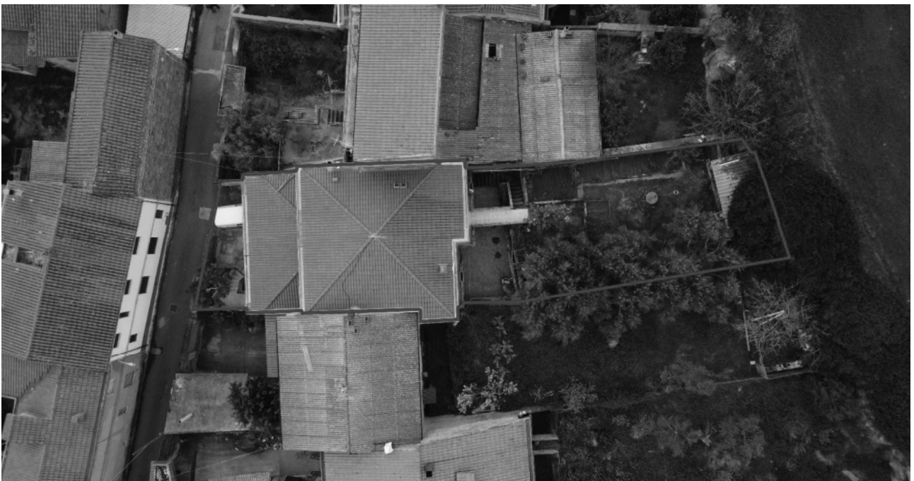
Foto 1 – vista aerea del lotto
